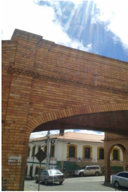
Fig.21 Detalle pared de enjuta (Fuente: Autores)
