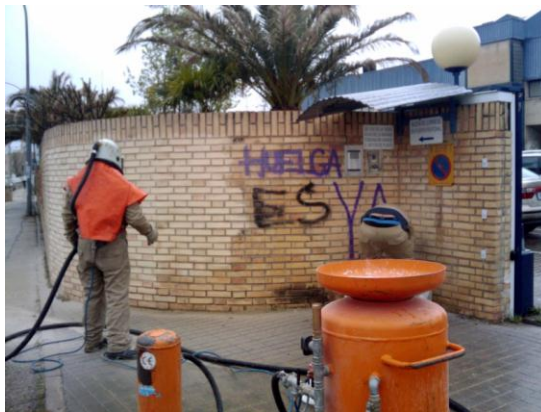
Fig.34 Limpieza de grafitis (Fuente: araquemaqueda.com/blog/limpieza-fachadas-rehabilitacion/ )
