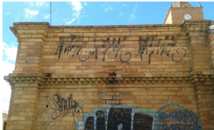
Fig.24 Detalle barandas puente peatonal (Fuente: Autores)
