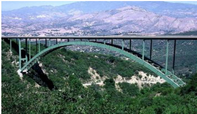
Fig.4 Puente del Cold Spring Canyon, Santa Barbara (USA). Longitud del vano: 365 m. (Fuente: Evaluación estructural de un puente a través de una prueba de carga estática 2005)
