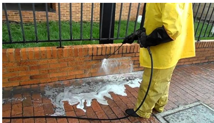
Fig.33 . Lavado de fachada (Fuente: www.youtube.com/watch?v=Azv73VhXtQ )
