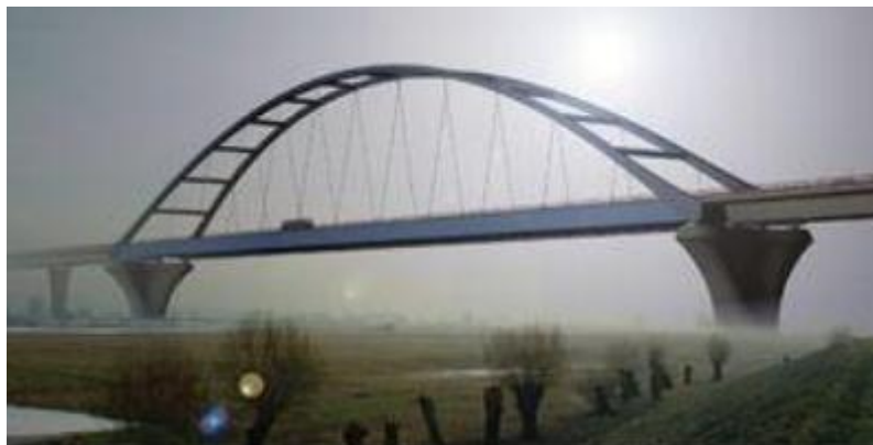
Fig.6 Puente de Tangermunde sobre el Elba, (Alemania). Longitud del vano: 185 (Fuente: Evaluación estructural de un puente a través de una prueba de carga estática 2005)
