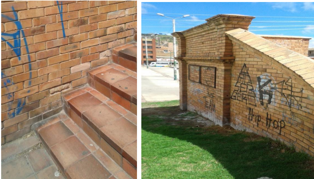
Fig.25 Detalle muro confinamiento de escaleras. (Fuente: Autores)
