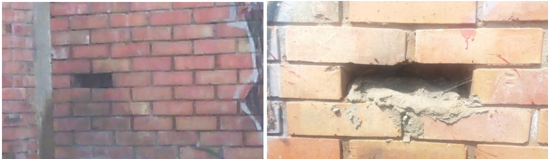
Fig.27 Extracción de muestras para el análisis (Fuente: Autores)
