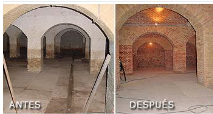
Fig.37 Esquema de antes y despues del tratamiento (Fuente:promurhumedades.es)
