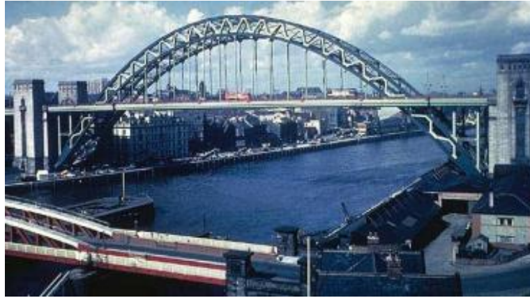
Fig.5 Puente de Fremont, Portland (USA), 1973. Longitud del vano: 383 m. (Fuente: Evaluación estructural de un puente a través de una prueba de carga estática 2005)
