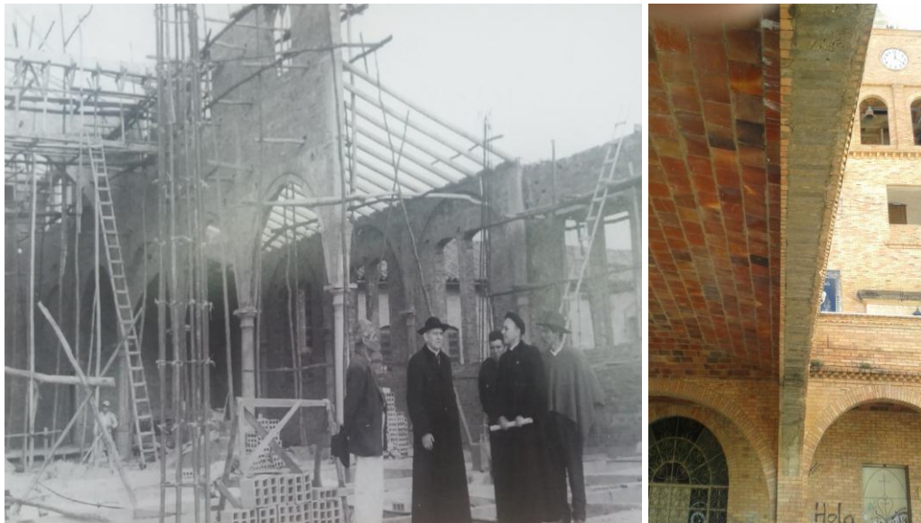
Fig.18 Construcción Iglesia las Nieves. Uso de concretos reforzados (Fuentes: Historia Salesiana Tunja. Sep/2003 y propia)
