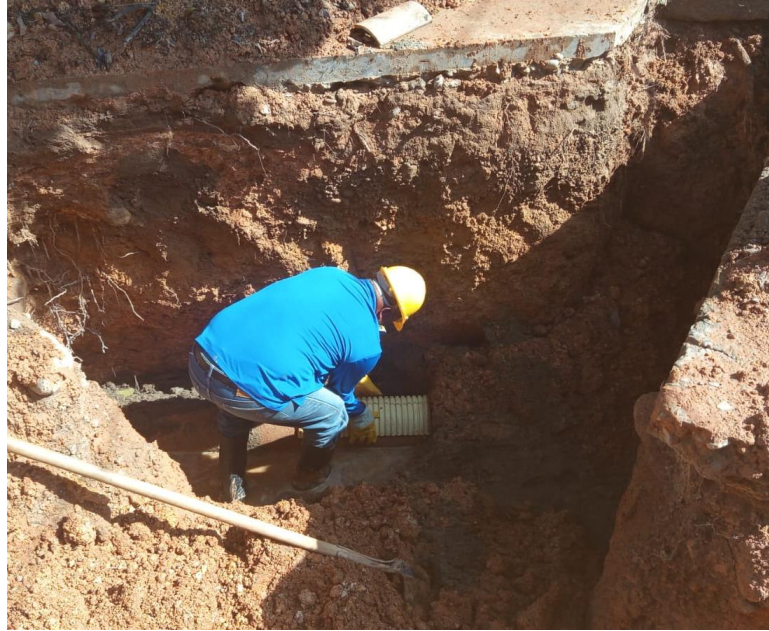
Figura 10. Reparación de tubería de alcantarillado
