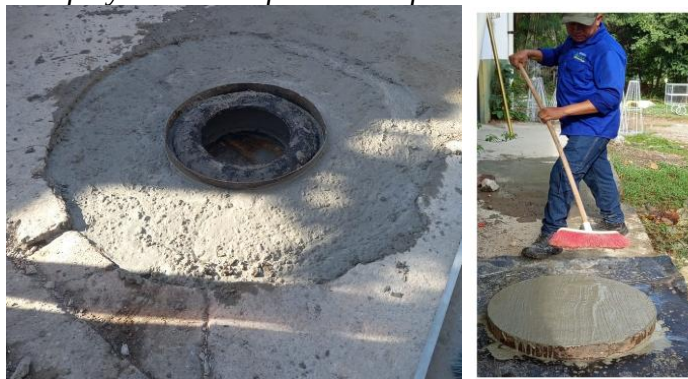
Figura 14. Construcción de tapa y corona de pozo de inspección
