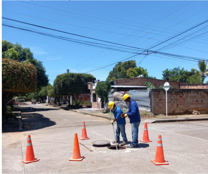
Figura 16. Mantenimiento de pozo de inspección
