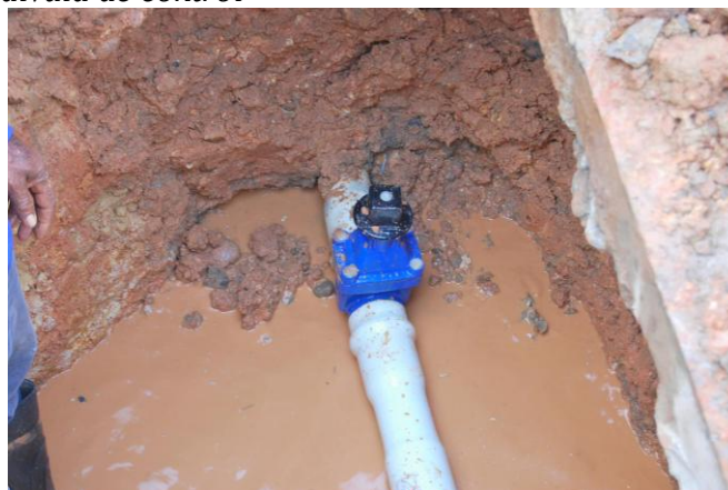
Figura 9. Instalación de válvula de control
