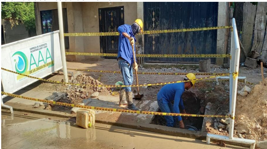
Figura 15. Reparación de acometida domiciliaria
