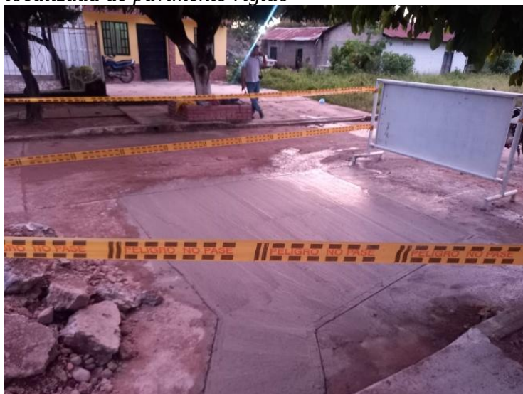
Figura 11. Reparación localizada de pavimento rígido
