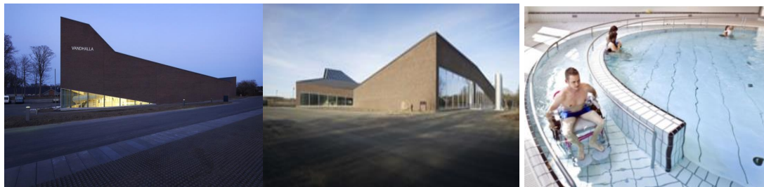
Figura 7. Centro de rehabilitación Vandhalla.
