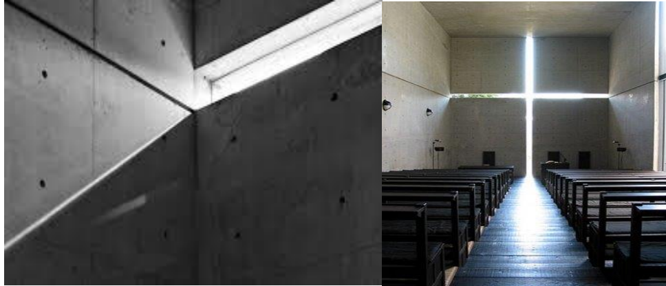
Figura 5. Marcas del encofrado en el hormigón.
