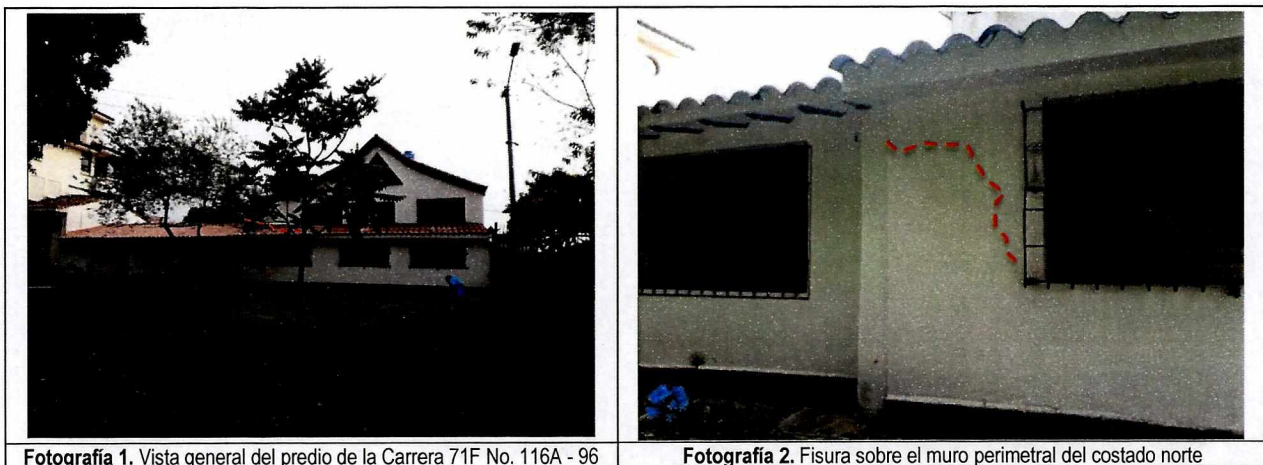
Fotografía 1. Vista general del predio de la Carrera 71F No. 116A - 96
