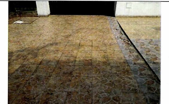
Fotografía 8. Vista general de del área del parqueadero – antejardín de la vivienda.
