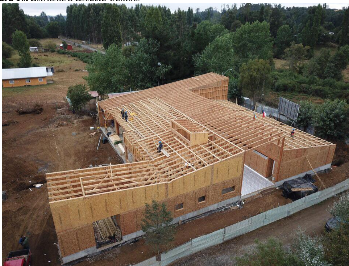
Figura 16. Estructura Escuela Cantino
