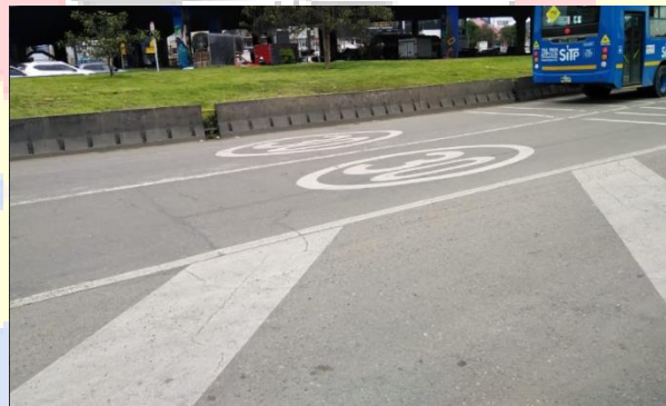
Ilustración 21. Señal horizontal. Av. Boyacá – Calle 80
