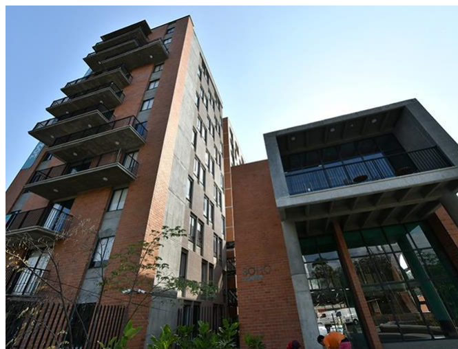
Figura 31. Fachada principal de la residencia universitaria Boho By Esstudia en Cali.
