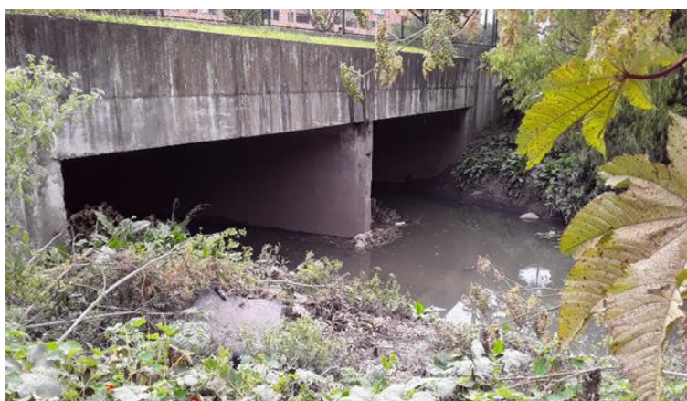
Ilustración 10. Box Culvert calle 127
