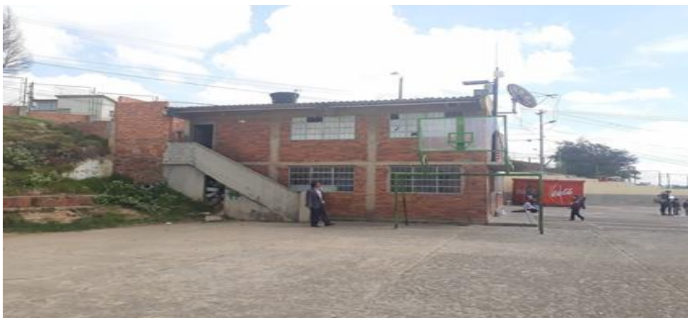
Imagen N° 6: Fachada lateral colegio Rojas Pinilla (club de leones)
