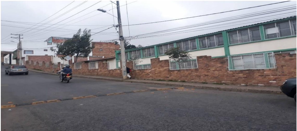
Imagen N° 10: Cerramiento Frontal del colegio Carlos Arturo Torres (Américas)
