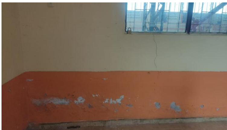
Figura. 9. Fisuras Mampostería
