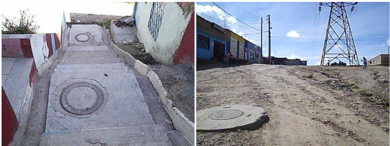
Ilustración 6 Red de Alcantarillado instalado vista de campo, Fotos propias.
