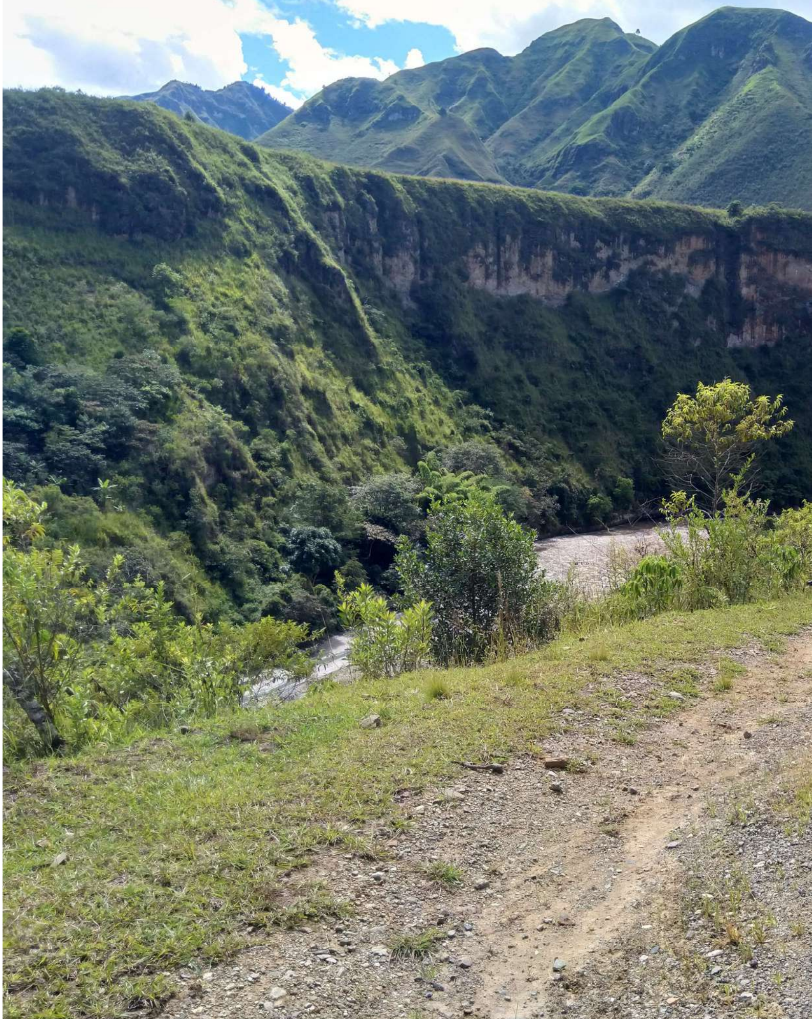
Carretera que conduce al Municipio de Páez , en el departamento del Cauca – Imagen Propia
