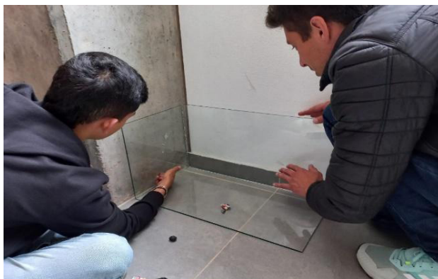
Ilustración 31. Construcción del tanque
