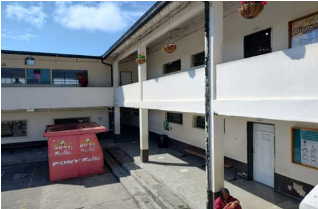
Imagen 20 Fotografía en las fachadas internas, Fuente: Propia
