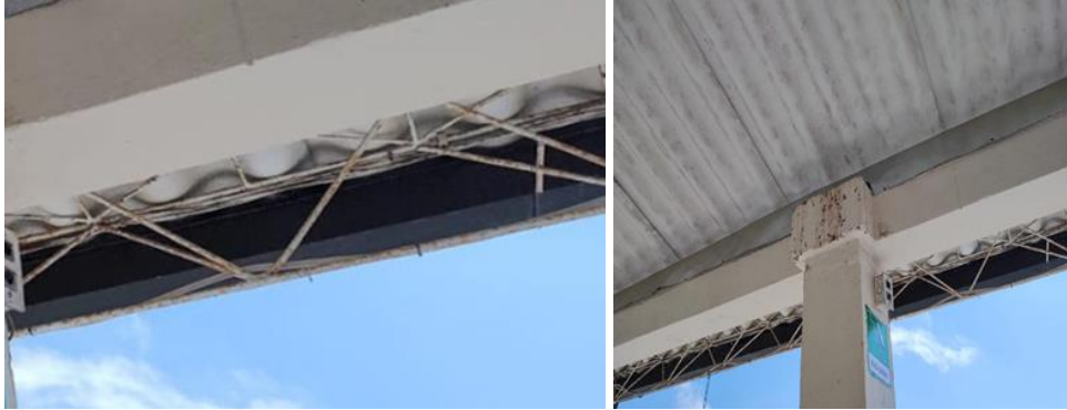
Imagen 25 Fotografía en cercha, Fuente: Propia
