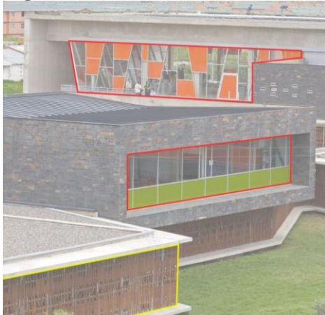
Figura 29. Detalle de ventaneria
