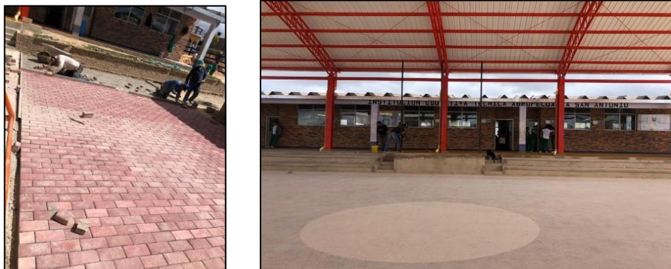
Ilustración 21: Polideportivo de la Vereda San Antonio.
