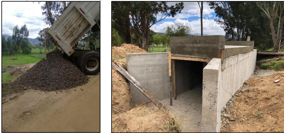
Ilustración 5: Compactación del recebo y estado final de la obra.
