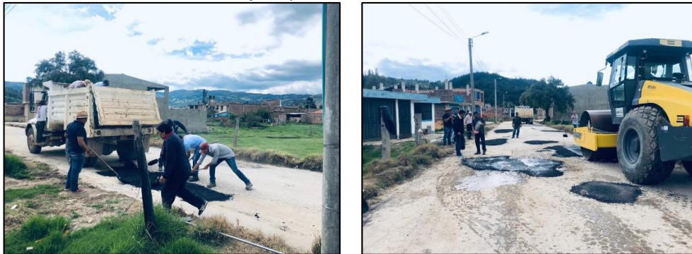
Ilustración 16: Rehabilitación de la base y carpeta asfáltica de la calle del Amor
