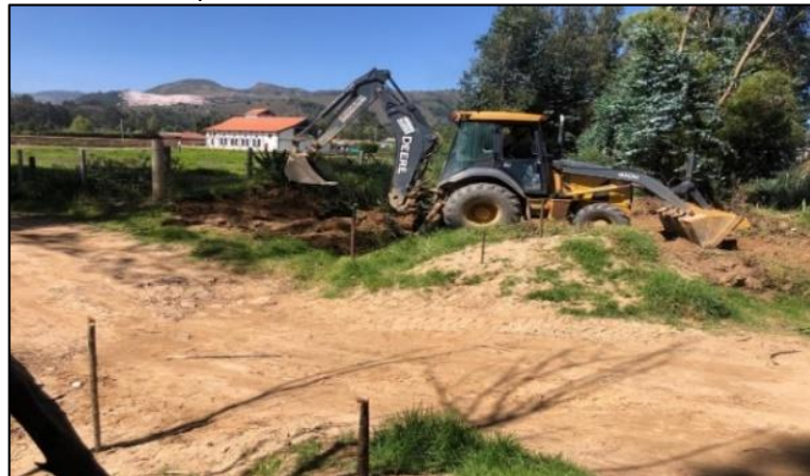
Ilustración 3: Excavación mecánica para la instalación del Box Culvert
