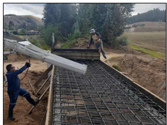
Ilustración 4: Fundición de Muros y Placa de resistencia al concreto de 4000 PSI
