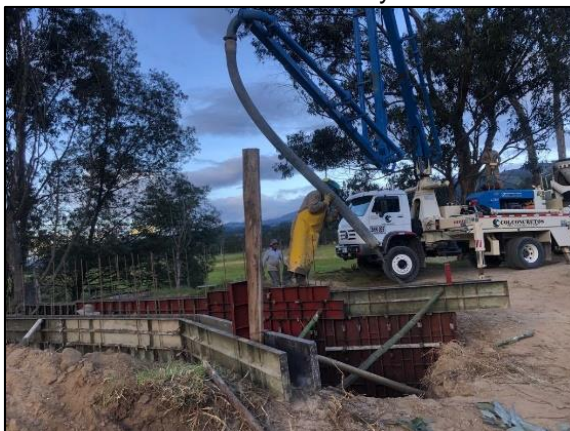
Ilustración 4: Fundición de Muros y Placa de resistencia al concreto de 4000 PSI
