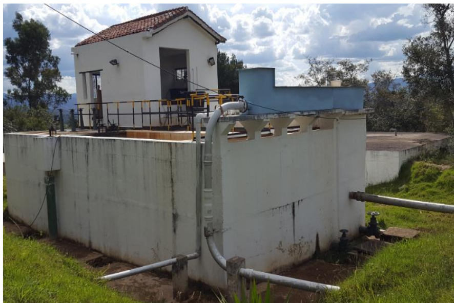
Imagen 8: Planta de Tratamiento de Agua Potable
