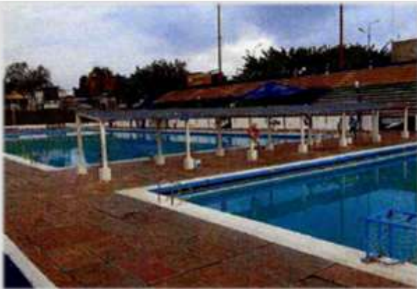
Piscinas. Se proyectó remodelarlas y demoler las graderías junto a la plaza para construir el edificio de artes marciales*
