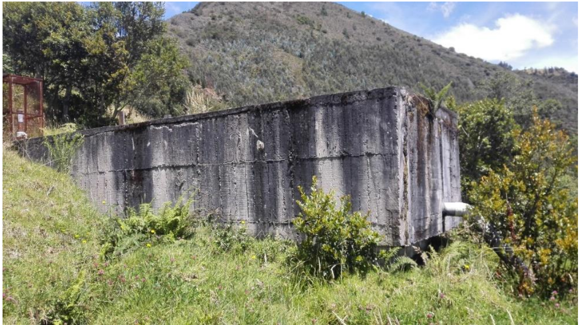
Fotografía 15. Desarenador. Municipio de Sotaquirá.
