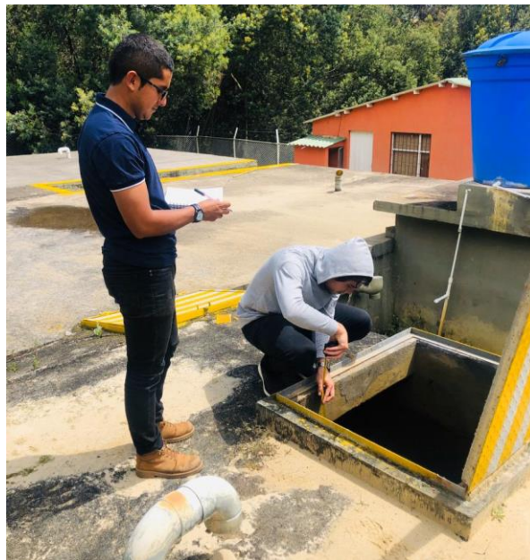
Fotografía 26. Prueba de lámina de agua. Municipio de Saboyá
