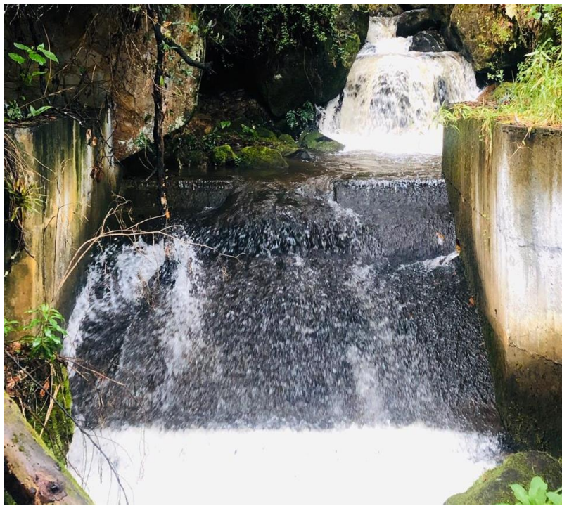
Fotografía 11. Fuente y estructura de captación. Municipio de Saboyá.
