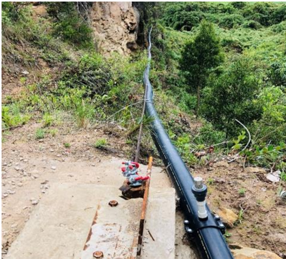
Fotografía 12. Paso elevado. Municipio de Oicatá
