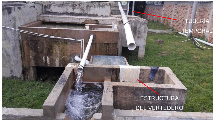
Fotografía 30. Tubería temporal para conducción de agua directa
