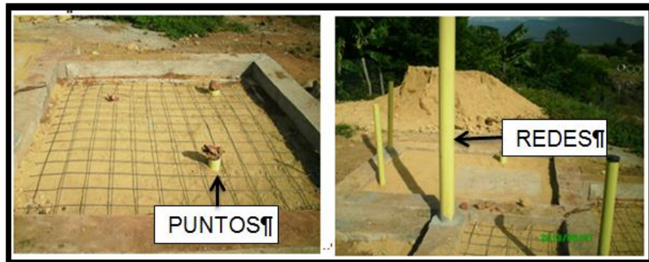
Figura. 81 Redes Hidrosanitarias
