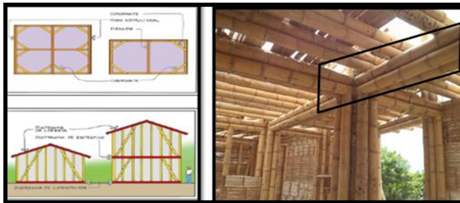
Figura. 79 Vigas Soleras
