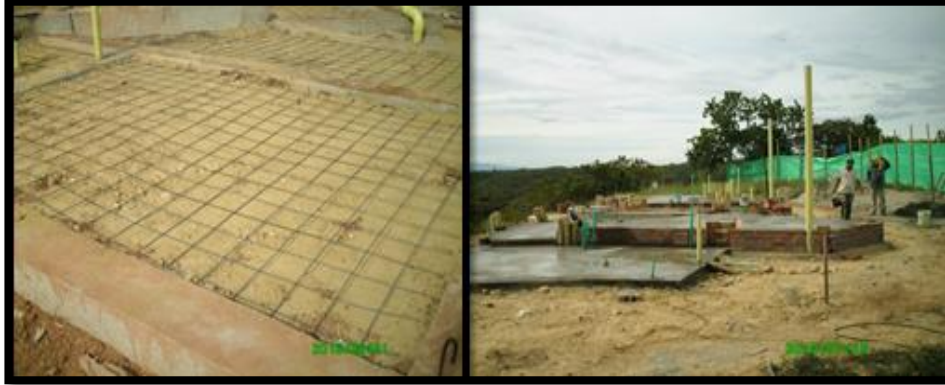
Figura. 76 Armado Placa Concreto
