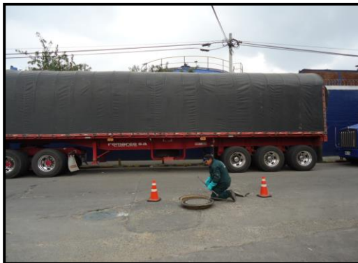
Fotografía 5. Levantamiento de las tapas de alcantarillado.
