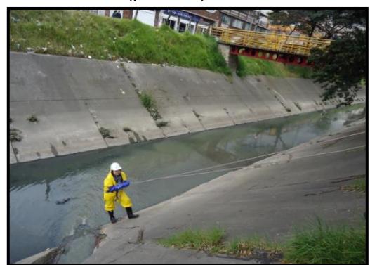
Fotografía 6. Ingreso al canal de los comuneros (pozo 1).
