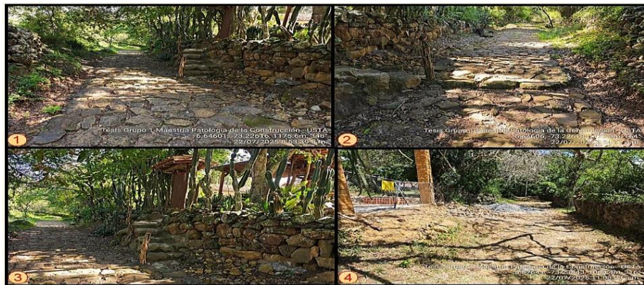
Figura 20. Intervención violatoria de la Ley y ausencia de Control
