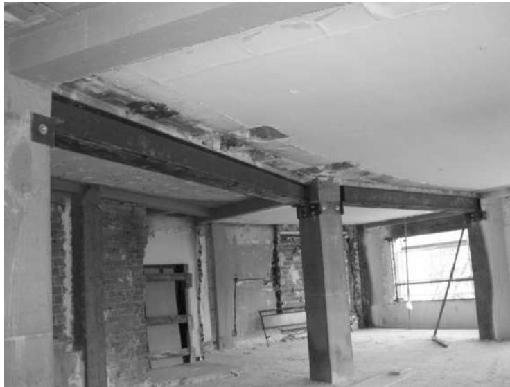
Figura 31. Encamisado metálico de Vigas. Fuente: Epachón (2013)
