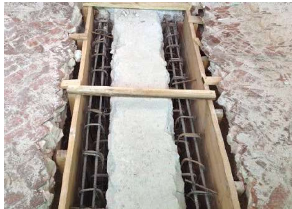
Figura 28. Recalce de Vigas. Fuente: Condiseing (2015)
