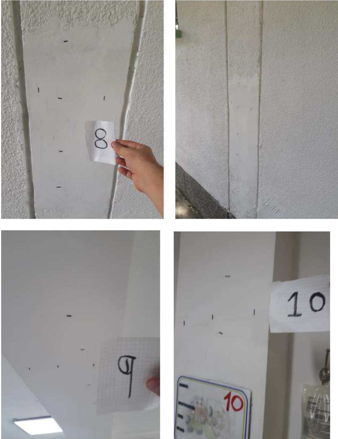
Figuras 10. Localización de Puntos 8, 9 y 10 para Mapeo de Aceros. Fuente: Elaboración propia
