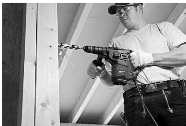
Figura 29. Perforación con martillo Rotopercusor. Fuente: Martillos Perforadores (2019)
