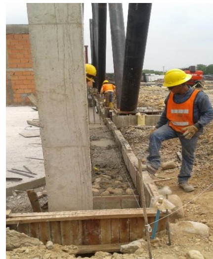
Fotografía 2. Vaciado de concreto ciclópeo viga pedestal 1 y 2 modulo 1
