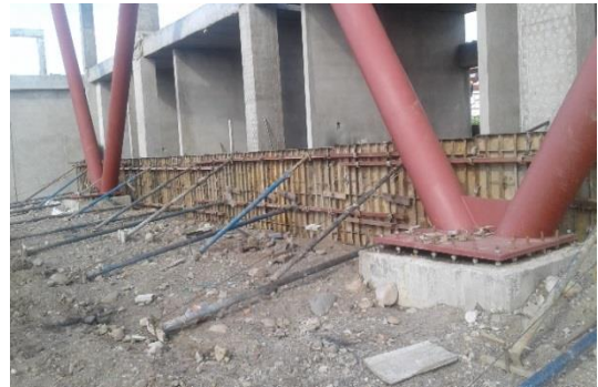
Fotografía 4. Instalación de formaleta VP4.Mod 2.
