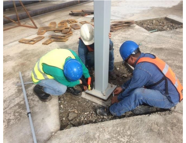
Fotografía 50. Nivelación topográfica platinas Viga IP
