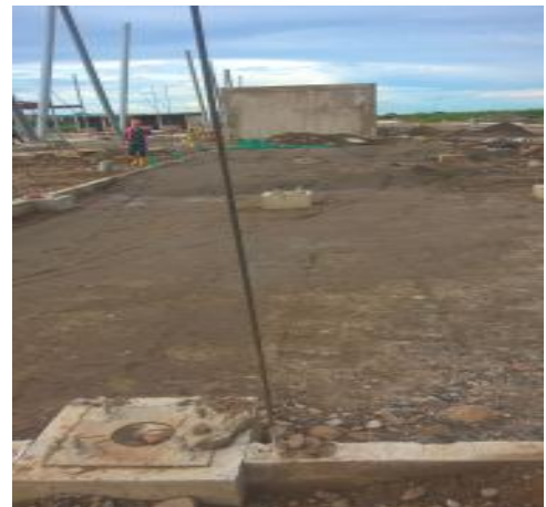
Fotografía 21. Conformación y relleno torre de antenas en el módulo 2
