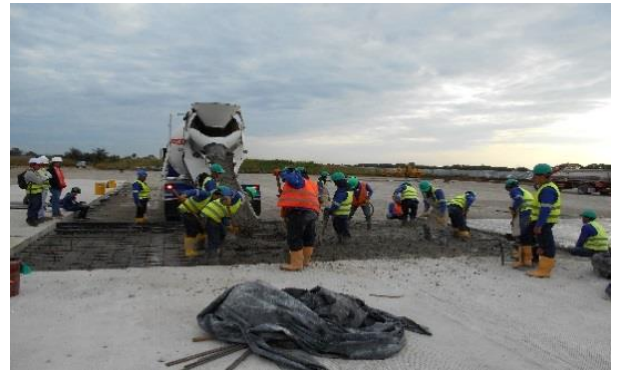
Fotografía 46. Vaciado de MR-45 plataforma de aviones
