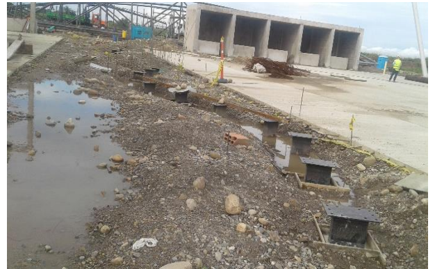
Fotografía 30. Testereado ménsulas viga zigzag
