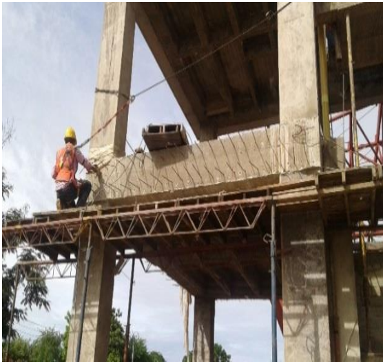
Fotografía 7. Construcción de alfajía 2do piso
