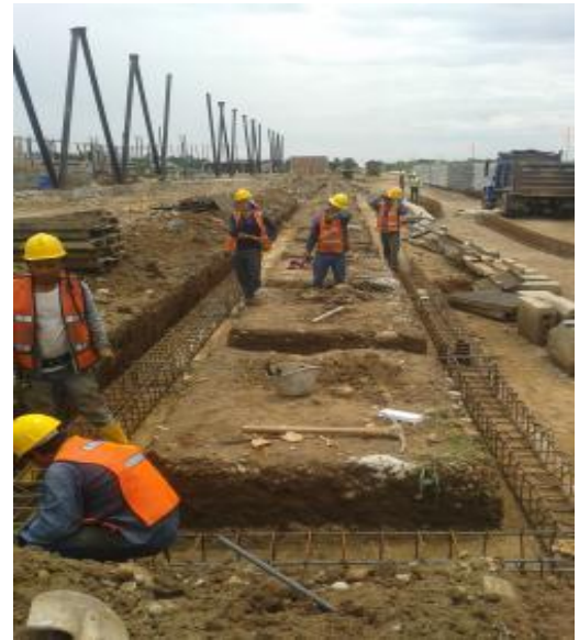
Fotografía 10. Instalación de acero vigas pasarela.
