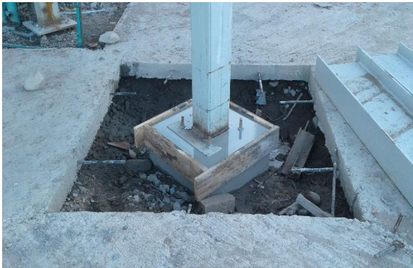
Fotografía 29. Grouting mezanine 1, módulo2
