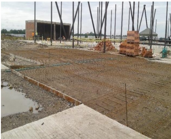
Fotografía 20. Colocación de la malla electro soldada contra piso módulo 1 y 2
