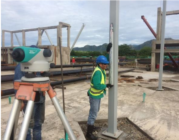
Fotografía 49. Toma de verticalidad Viga IP
