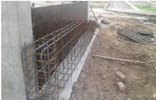
Fotografía 3. Instalación de formaleta VP1. Mod1.
