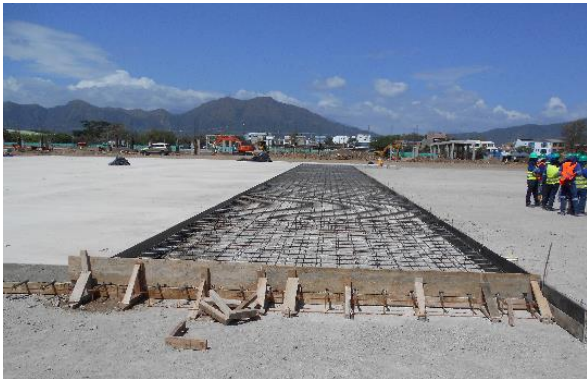
Fotografía 45. Instalación de fórmata, plataforma de aviones
