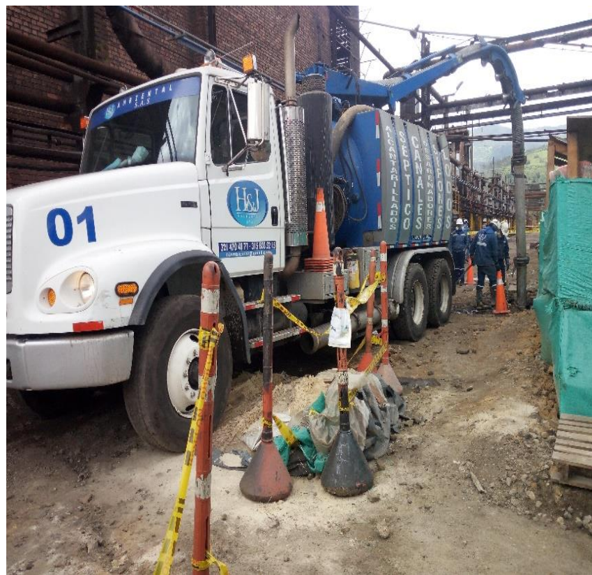
Fotografía 5. Mantenimiento Cámara de alcantarillado
