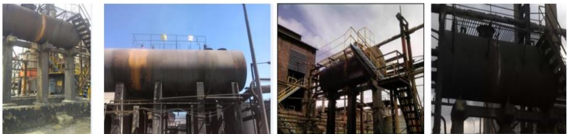
Fotografía 14. Antiguo tanque de almacenamiento de ácido sulfúrico
