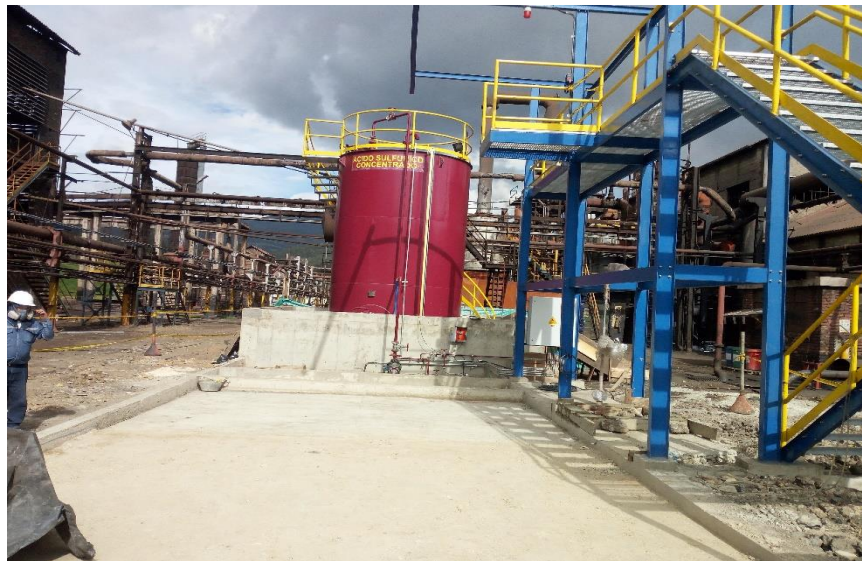
Fotografía 4. Montaje de Tanque, Plataforma de descargue y rampa de descargue
