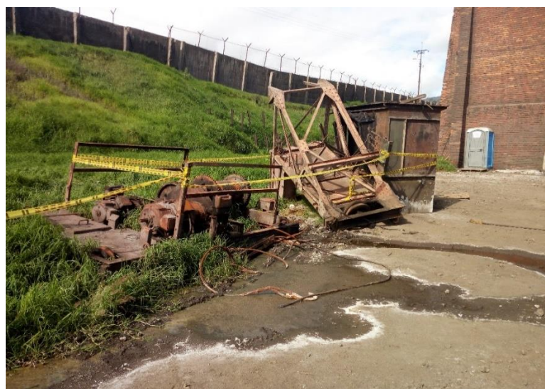
Fotografía 11. Desmontaje puente grúa
