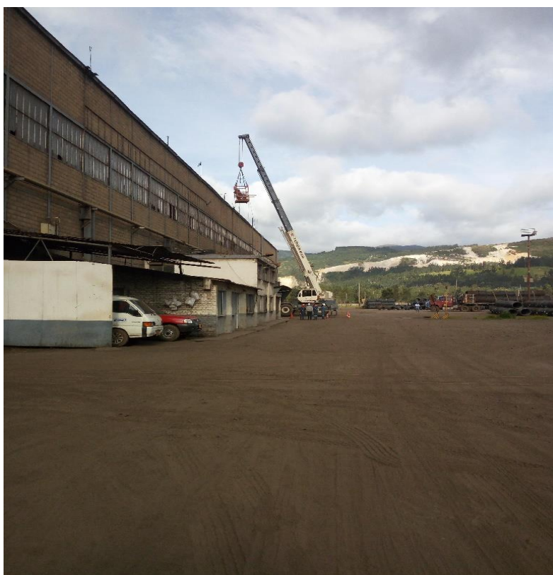
Fotografía 12. Mantenimiento y construcción Techos
