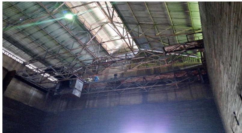
Fotografía 10. Puente grúa a desmontar
