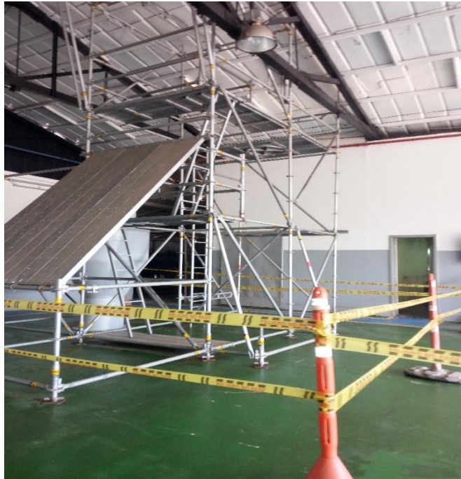
Fotografía 9. Torre de trabajo en alturas
