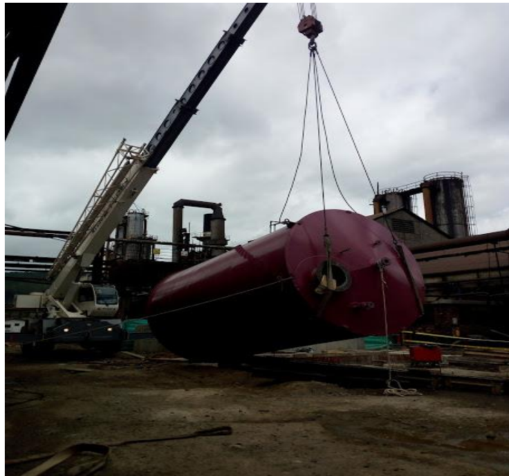
Fotografía 3. Izaje de carga Tanque
