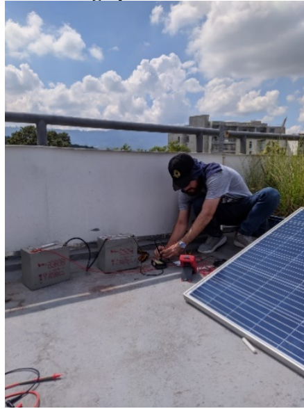
Figura 38. Prueba de controlador de carga y baterías
