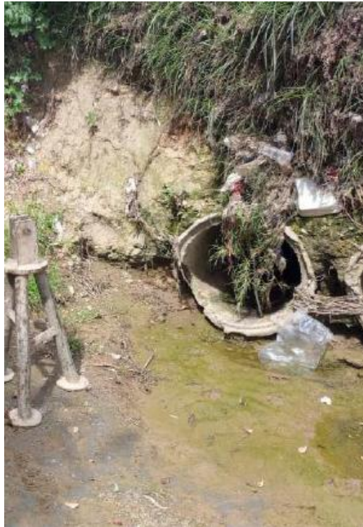
Figura 29: Tubería Cruce Diagonal 38 con Carrera 12, Antes del Cruce.
