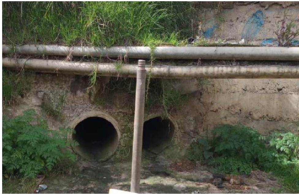
Figura 30: Tubería Cruce Diagonal 38 con Carrera 12, Después del Cruce.
