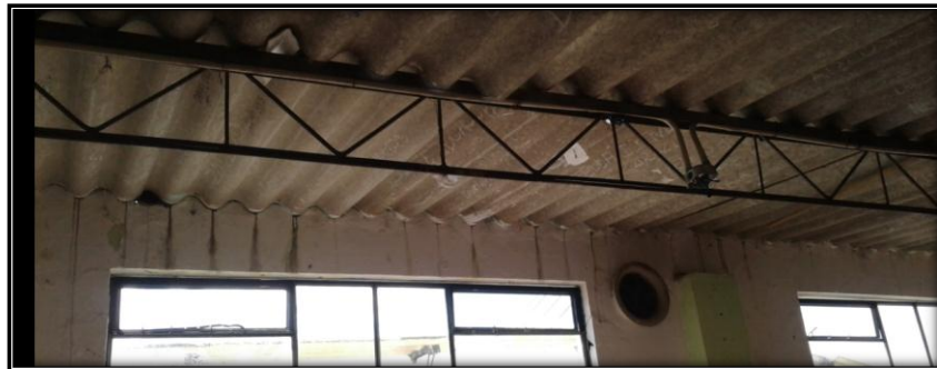
Ilustración 30 Estado de cubierta de la institución.
