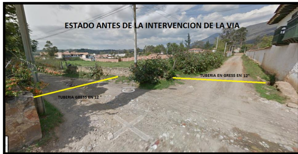
Ilustración 22 Estado antes de la intervención
