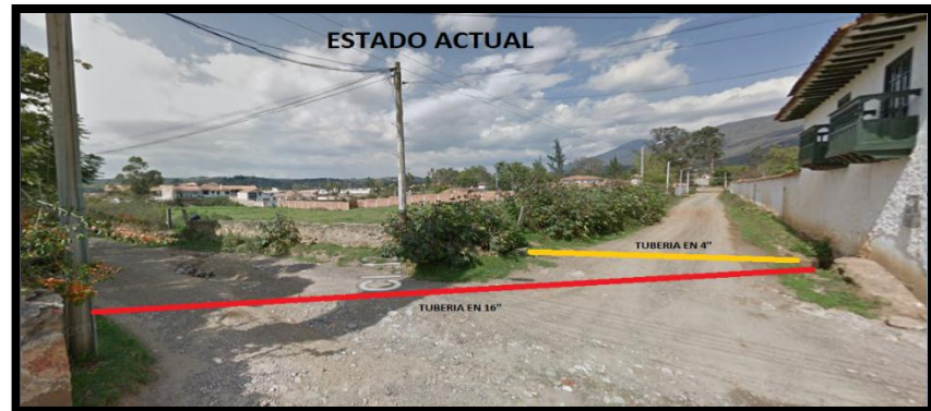
Ilustración 25 Estado actual de la vía
