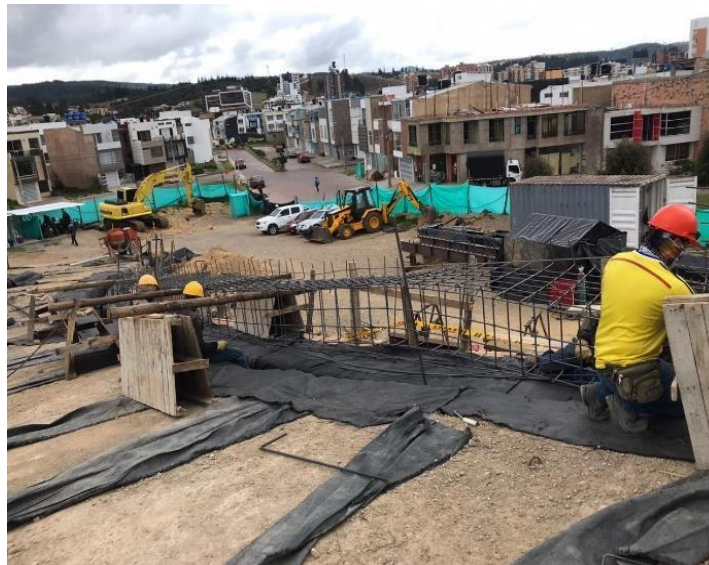
ILUSTRACION 9 Suministro Bordillo Frente 2.1
