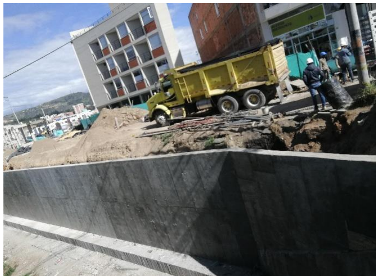
ILUSTRACION 6 Frente 1 Muro de contención terminado, zarpa y vástago fundido en totalidad.
