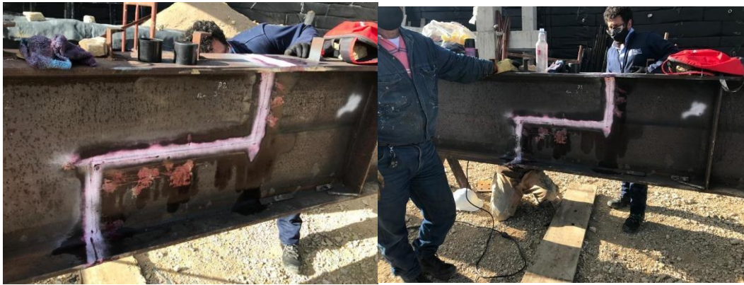
ILUSTRACION 19 prueba de tintas (estructura metálica)
