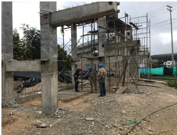
ILUSTRACION 4 Frente 1 rampa peatonal
