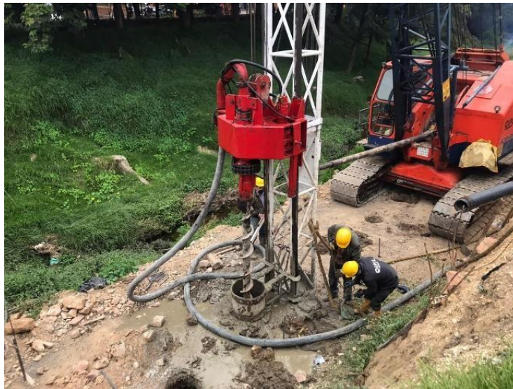
ILUSTRACION 5 Frente 1 Zona de pilotaje para posterior fundida de zarpa en muro de contención
