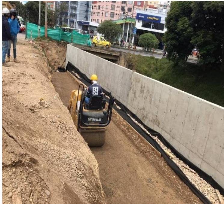
ILUSTRACION 7 Muro de contención, compactación material de relleno
