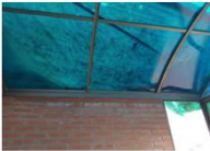
Fotografía 4: Cubierta tapada con polisonombra y viga canal tapada con material de obra contigua
