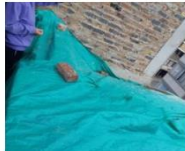
Fotografía 3: Cubierta tapada con polisonombra y viga canal tapada con material de obra contigua
