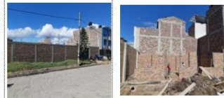
Fotografía 1: Vista exterior cerramiento
