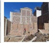
Fotografía 2: Vista lateral cerramiento
