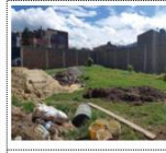
Fotografía 3: Vista interna de obra
