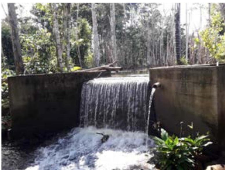
Imagen 66. Bocatoma del acueducto veredal La Cristalina.
