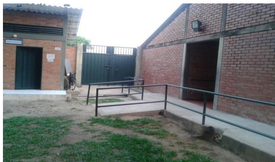
Fotografía N°36. Rampla de acceso
