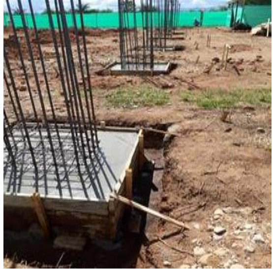
Fotografía N°4. Fundición de Zapatas
