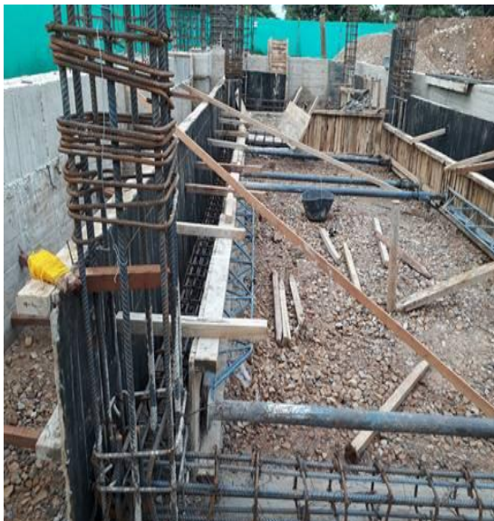
Fotografía N°5. Hierros de columnas y vigas de cimentación.
