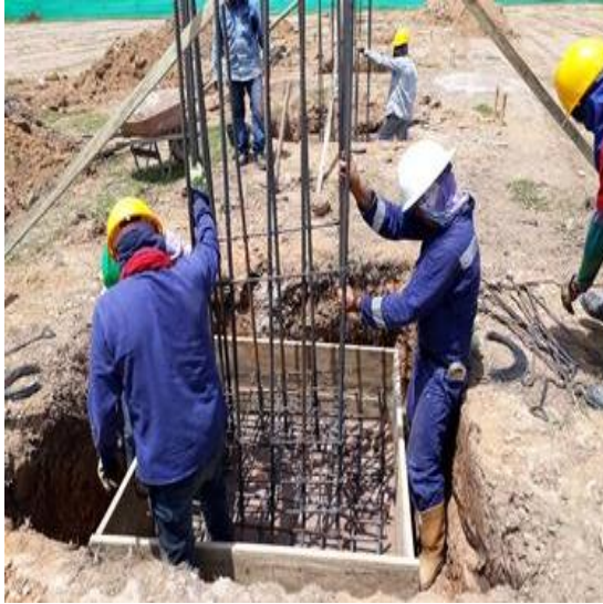
Fotografía N°3. Encofre de Zapatas
