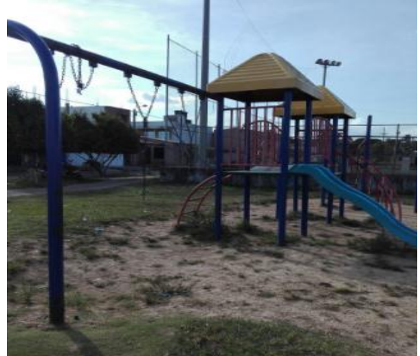
Fotografía N°26. Estructura existente Parque Infantil
