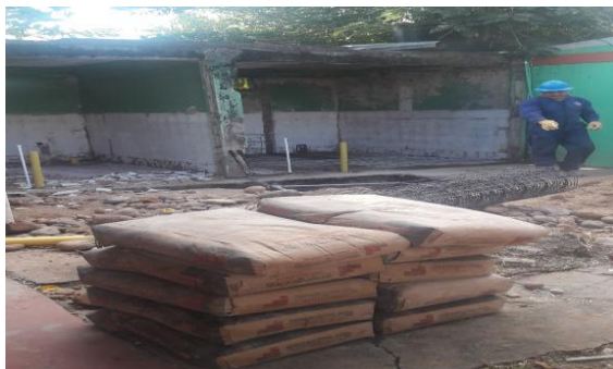
Fotografía N°32. Desmonte de sanitarios de baños exteriores.
