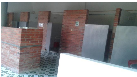
Fotografía N°37. Puertas nuevas en los baños
