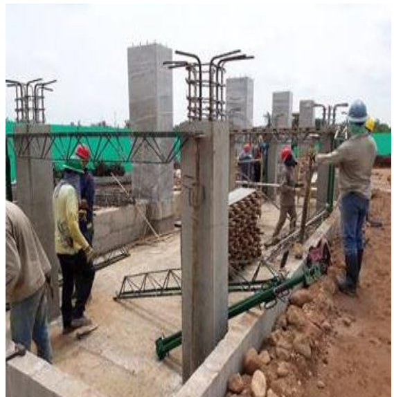
Fotografía N°6. Fundición de columnas y vigas de cimentación.
