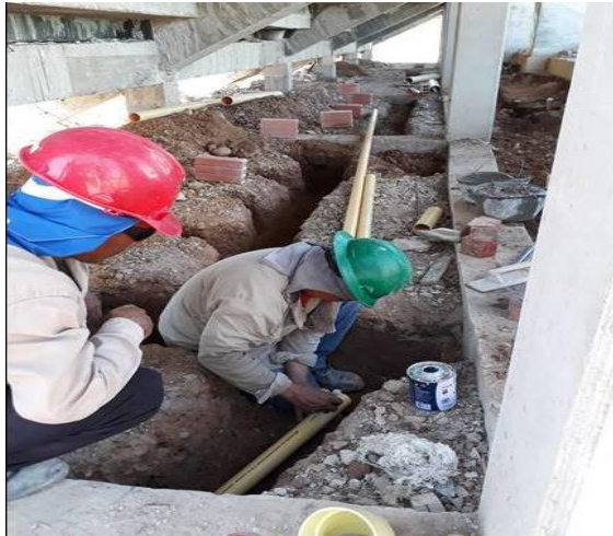
Fotografía N°7. Instalación de tubería hidrosanitaria
