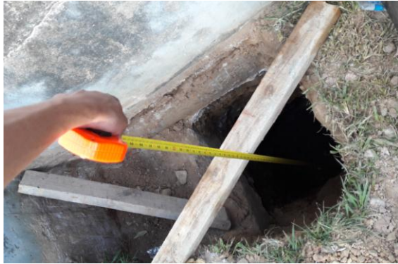
Fotografía N°20. Apertura del hueco
