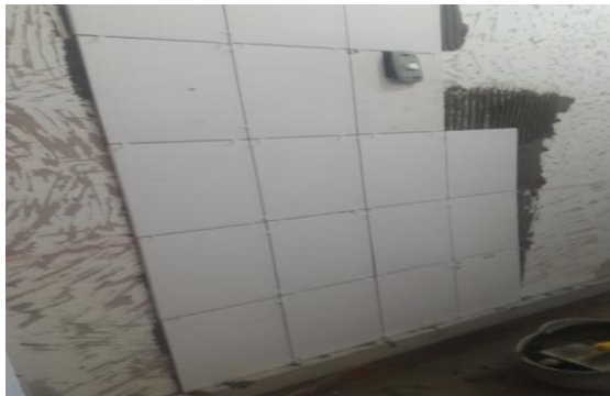
Fotografía N°34. Enchape muro de baños interiores.
