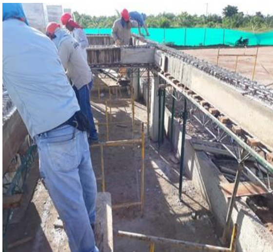
Fotografía N°9. Amarre de hierro viga aérea.
