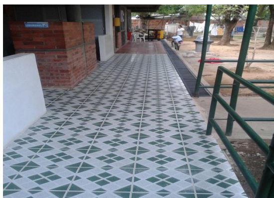
Fotografía N°38. Enchape piso corredor de baños
