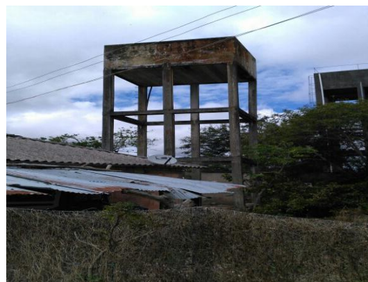
Fotografía N°41. Tanque de almacenamiento de agua.
