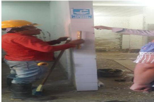
Fotografía N°35. Enchape baños interiores
