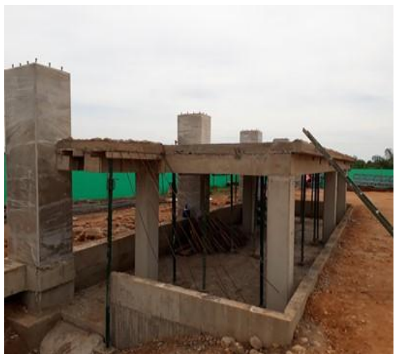
Fotografía N°10. Fundición de concretos, tarima
