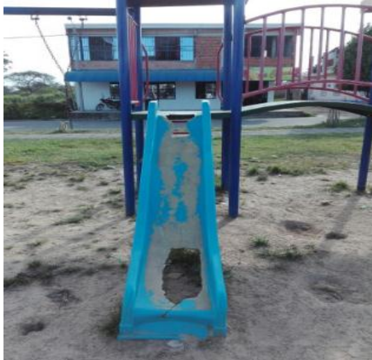
Fotografía N°25. Resbaladero en malas condiciones.
