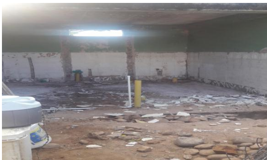
Fotografía N°33. Demolición de muro y enchapes de baños exteriores.
