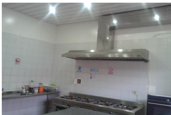
Fotografía N°39. Estado actual de la cocina
