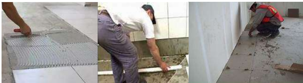
Figura 5. Proceso de instalación de enchape cerámico.
