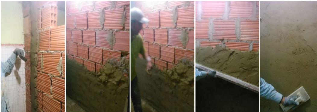
Figura 2. Proceso de aplicación de friso liso sobre muro
