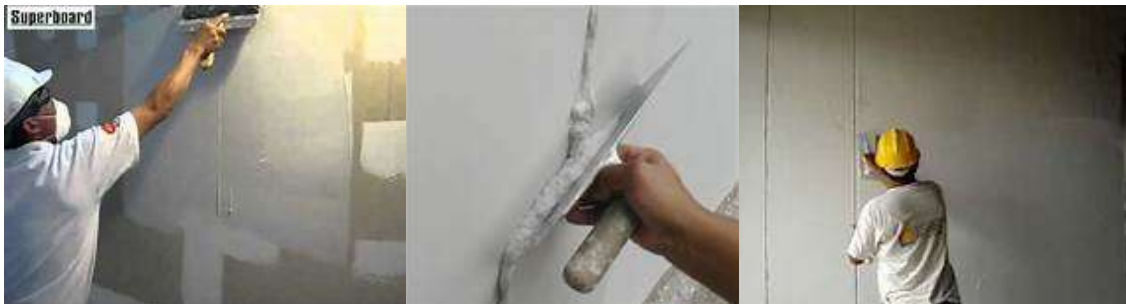
Figura 3. Proceso de aplicación de estuco en pared.
