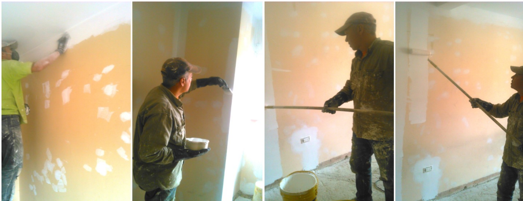
Figura 4. Proceso de aplicación de pintura en muros interiores.
