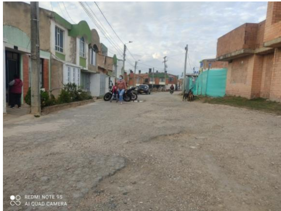
Foto 10 Tramo A vista final Cooservicios.
