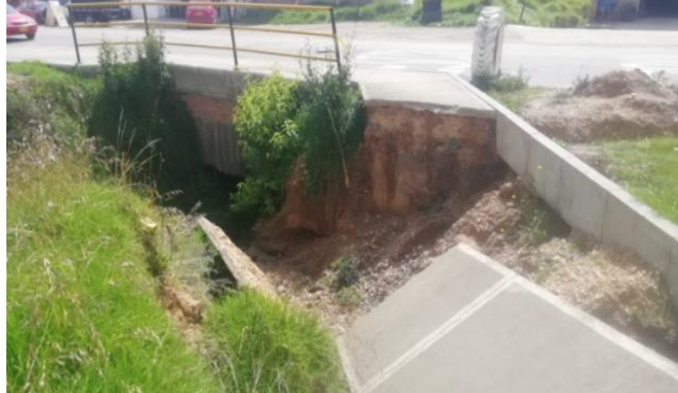
Foto 6 Anden Barrio La María – UPTC veterinaria vista inicial.
