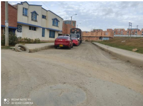
Foto 9 Tramo A cruce Cooservicios.
