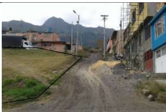
Foto 11. ZHF Parque Urb. Nueva Esperanza cesión tipo A.
