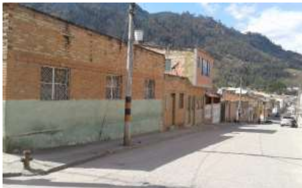
Foto 22. Tratamientos Urbanísticos de Renovación urbana.
