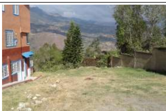
Foto 13. Tratamientos Urbanísticos de conservación ambiental ubicados sobre la Quebrada del Pueblo (Calle 6).
