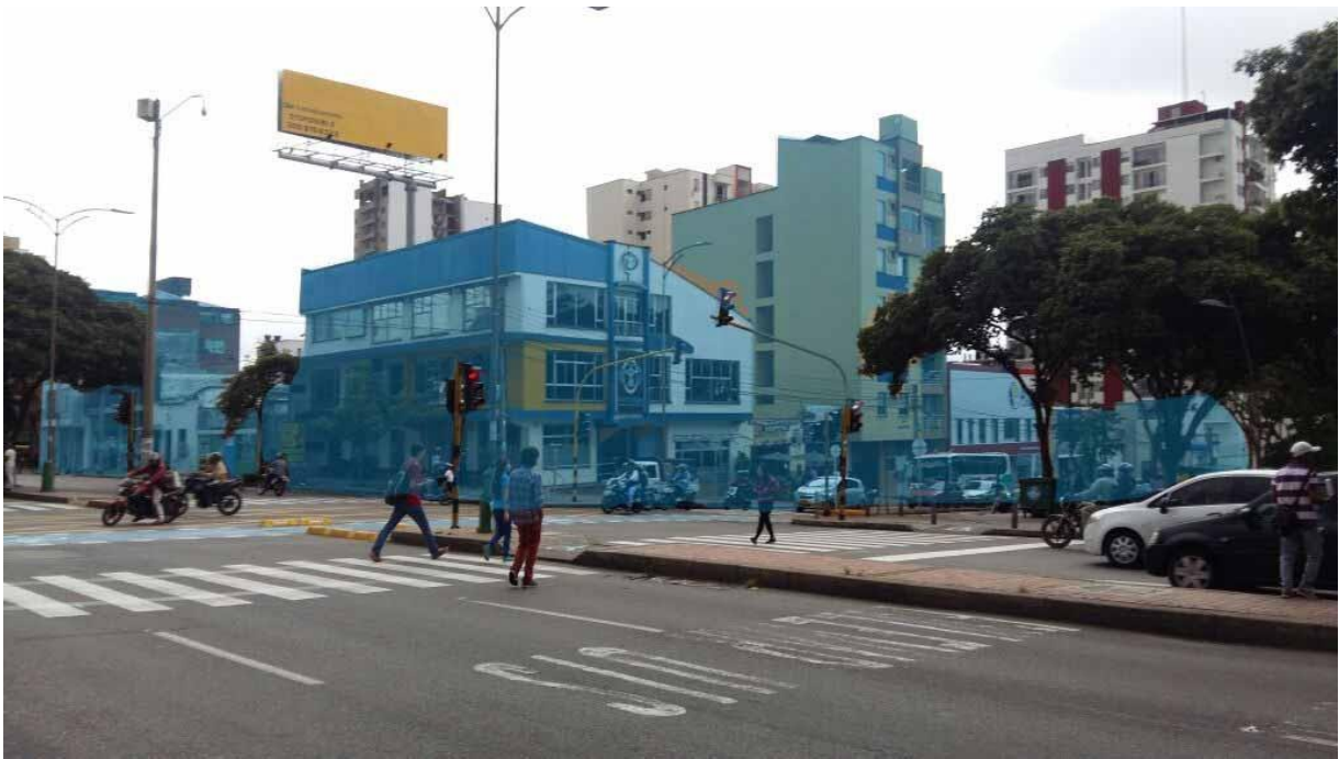
Figura 54. Fotografía lote 3, manzana a intervenir.
