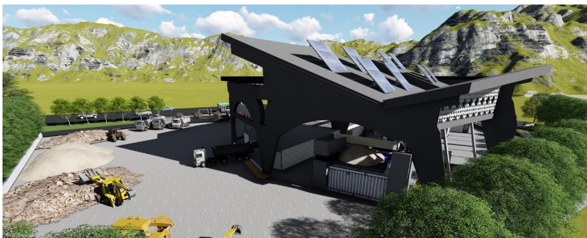
(Grafica N°36) Cubierta termo acústica y acopio
