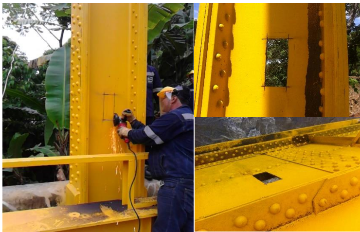
Imagen 24. Toma de muestra de acero en columnas de torres y vigas de rigidez para ensayo de tensión. Fuente: Instituto Nacional de Vías, Consortio IPV. 2015, JPS Ingeniería.
