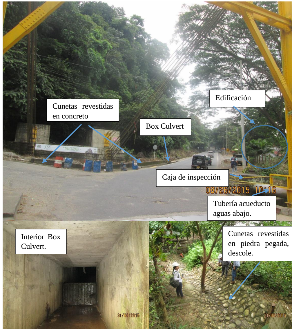
Imagen 4. Registro fotografico edificaciones y otras obras en la zona Oriental del puente. Fuente: Propia.
