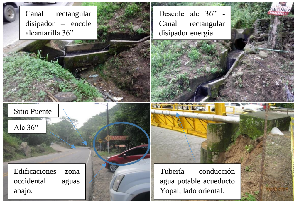
Imagen 2. Registro fotográfico edificaciones y otras obras en la zona occidental del puente. Fuente: Propia.
