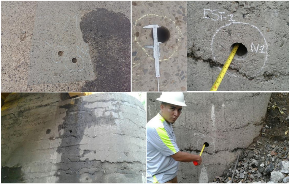
Imagen 94. Orificios de toma de núcleos en el tablero del puente y en el estribo ubicado en el margen derecho del río. Fuente: Propia.
