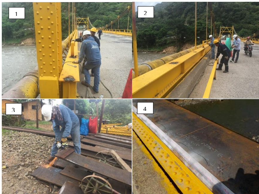
Imagen 19. 1-2. Retiro de la baranda con equipo de oxicorte; 3. Preparación cintas de acero para refuerzo vigas de rigidez; 4. Refuerzo de las vigas de rigidez con cintas de acero ASTM A-36. Fuente: Instituto Nacional de Vías, Consorcio Puentes La Cabuya 2015
