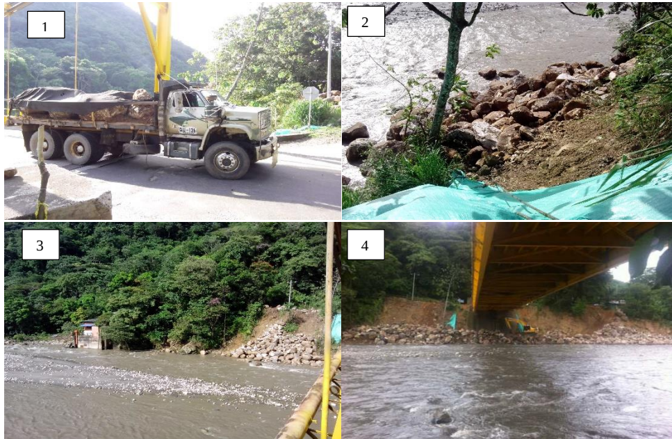
Imagen 20. 1. Camión con viaje de rocas diámetros de 1 a 1,20 m; 2. Disposición de las rocas y protección de los taludes con polisombra; 3. Vista desde el puente de la disposición de las rocas previo acomodamiento con máquina; 4. Conformación enrocado aguas arriba y abajo del puente margen izquierdo. Fuente: 1-3 Propia; 4 Instituto Nacional de Vías, Consorcio Puentes La Cabuya 2015
