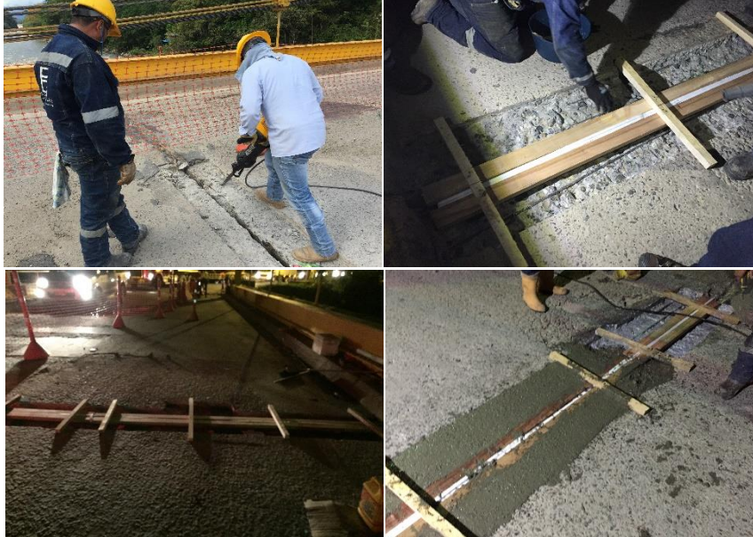
Imagen 22. Reparación junta de dilatación losa de concreto tablero. Fuente: Instituto Nacional de Vías, Consorcio Puentes La Cabuya 2015.
