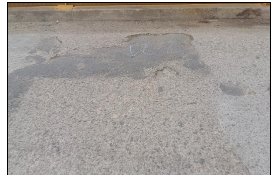
Imagen 68. Fisuras Transversales Z-19
