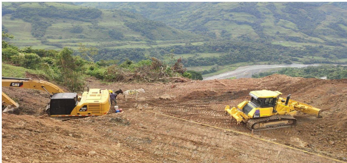
Figura 2. Obras en la Transversal del Cusiana
