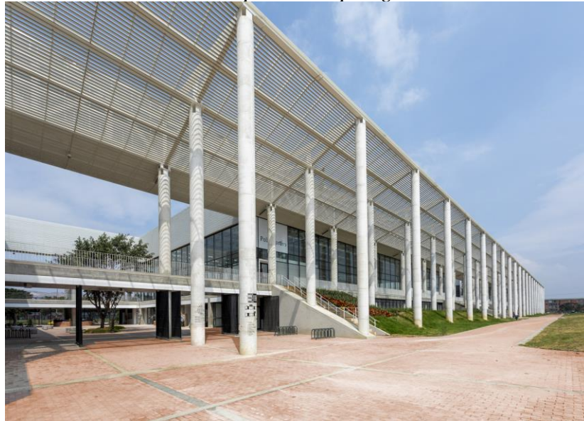
Figura 40. Fachada noroeste del escenario deportivo. Tipología 3
