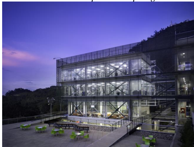
Figura 37. Fachada noroeste del escenario deportivo. Tipología 2
