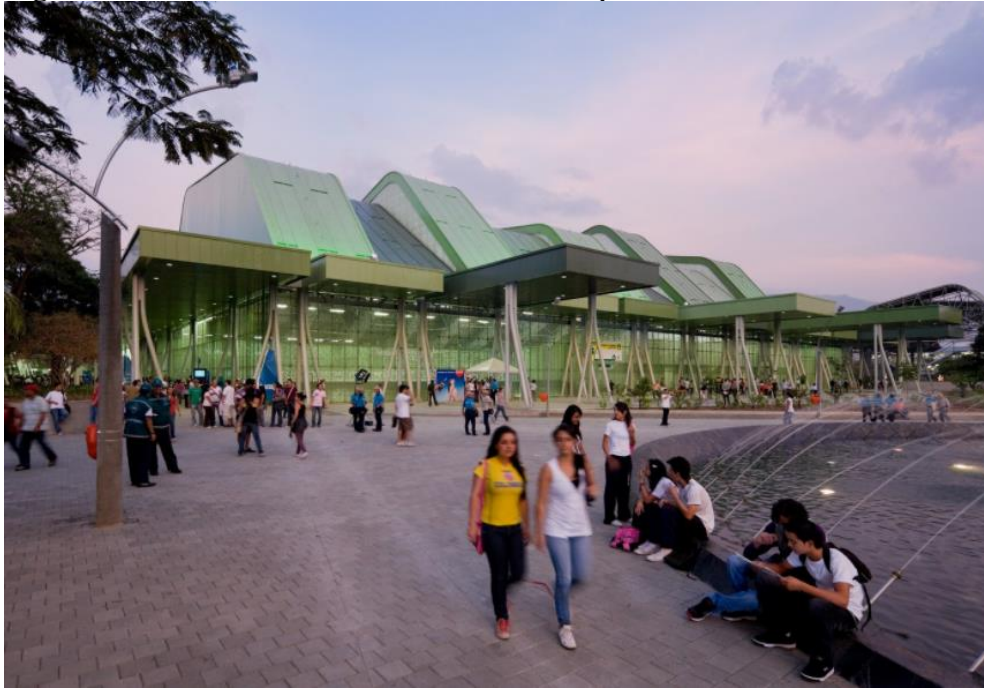
Figura 34. Fachada noroeste del escenario deportivo
