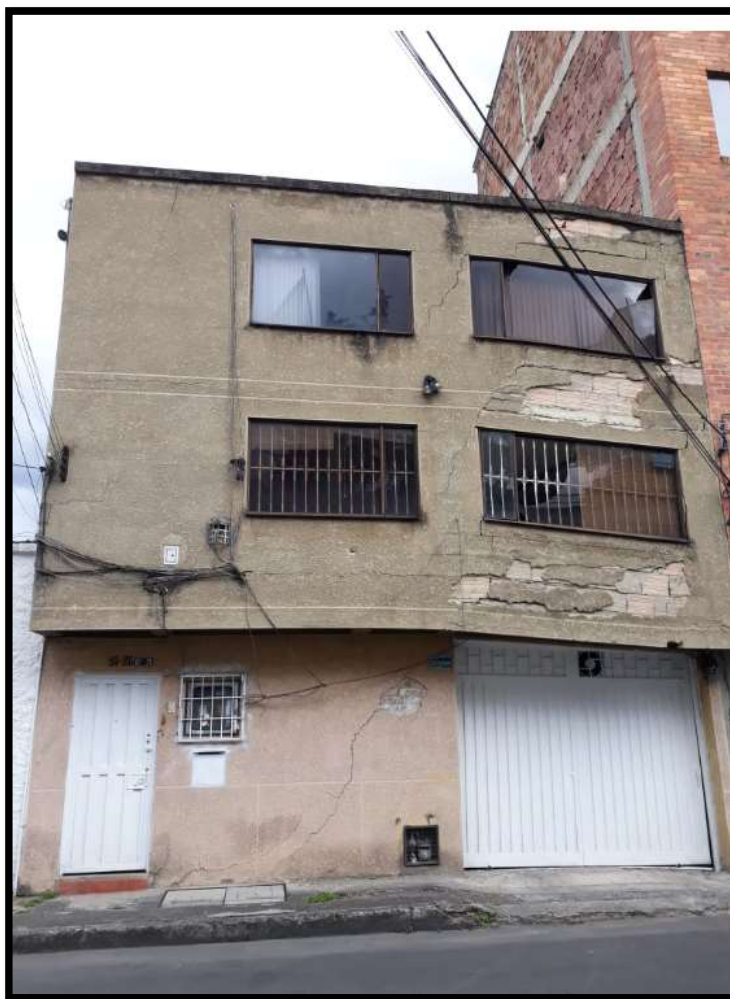
Imagen 18 Vivienda Barrio El Polo. Fuente Propia.
