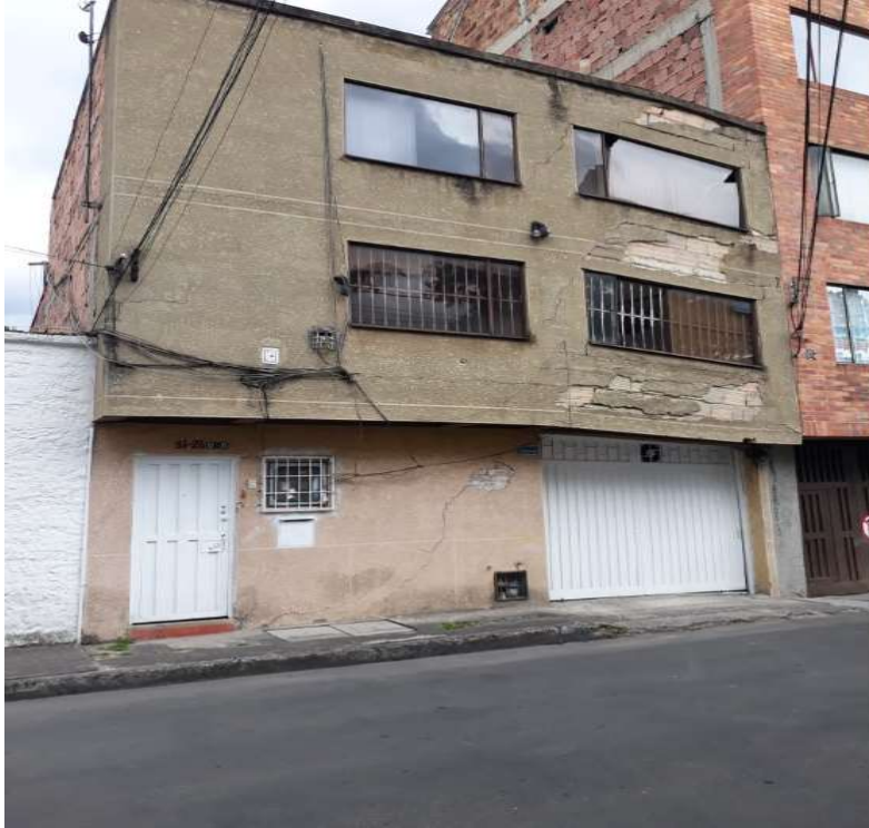
Imagen 2 Vivienda barrio El Polo. Fuente Propia.
