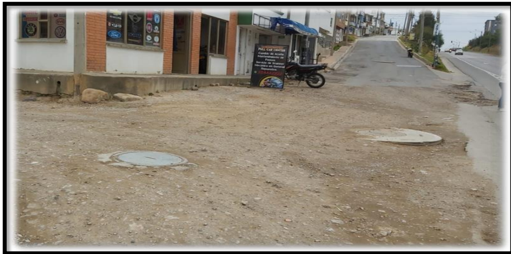
Figura 29. Tramo 2 B. carrera 6 a entre calle 73 y 74 paralela a av. Norte.
