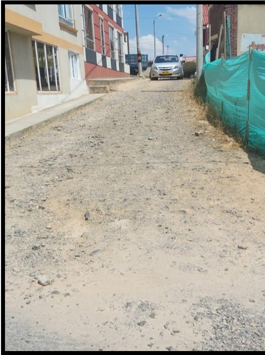
Figura 48. tramo 7 C. calle 17 entre calle 48 y calle 50.
