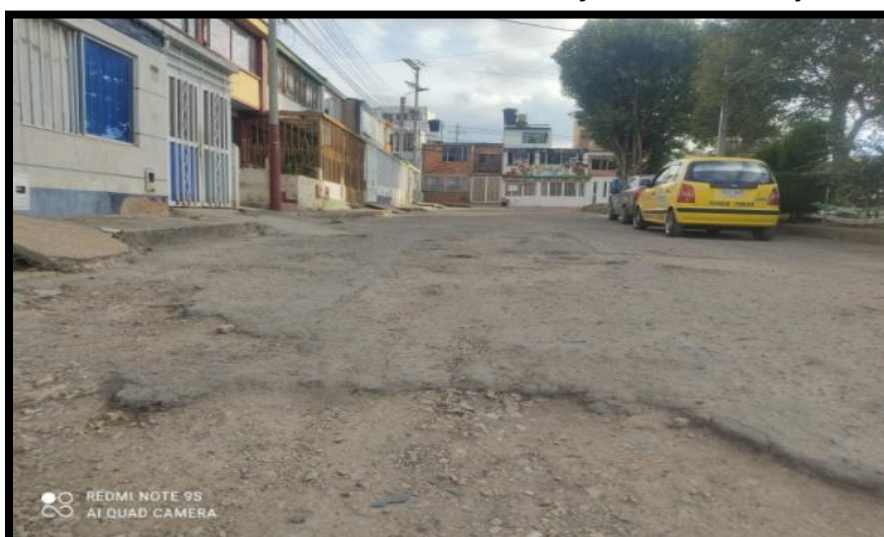
Figura 79. tramo 17 H. carrera 3 a entre calle 4 d y calle 4 c callejón interno.
