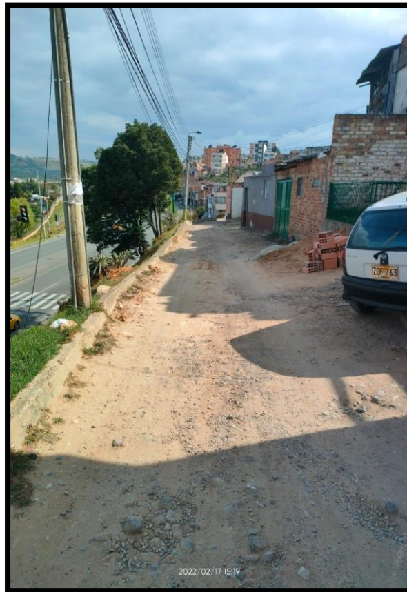
Figura 126. Tramo 32 A. carrera 7 entre calle 28 a y diagonal acceso de la av. oriental a carrera 7.
