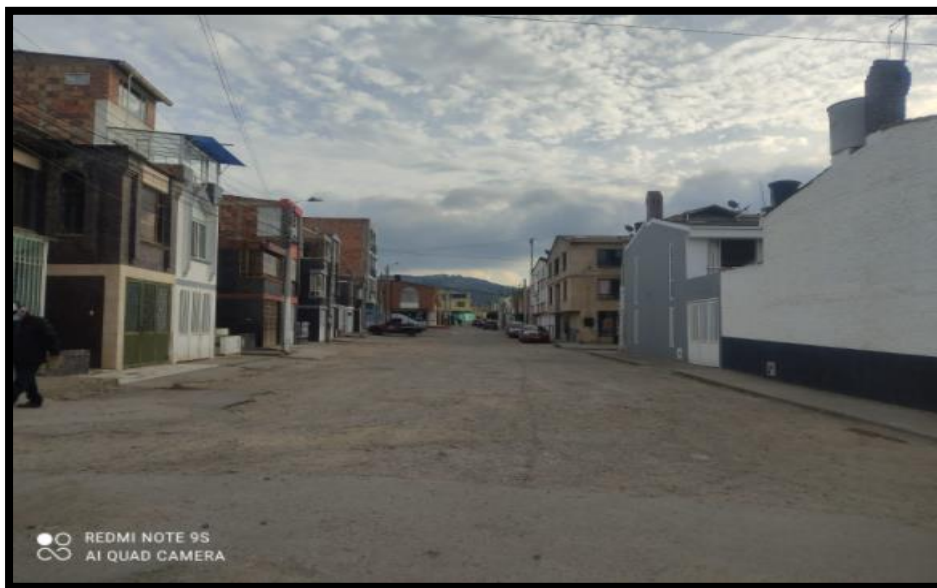
Figura 74. Tramo 17 C. cra 4 a entre calle 4 c y calle 4ª tramo con separador.
