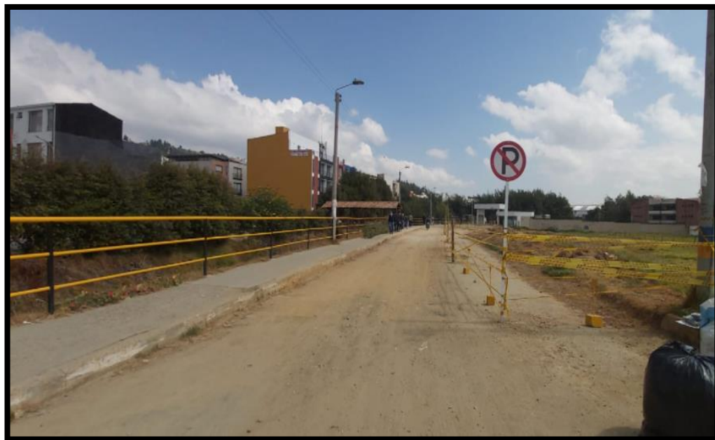
Figura 54. Tramo 9 B. carrera 12 con calle 38 entrada edificio Rafael azula u.p.t.c.
