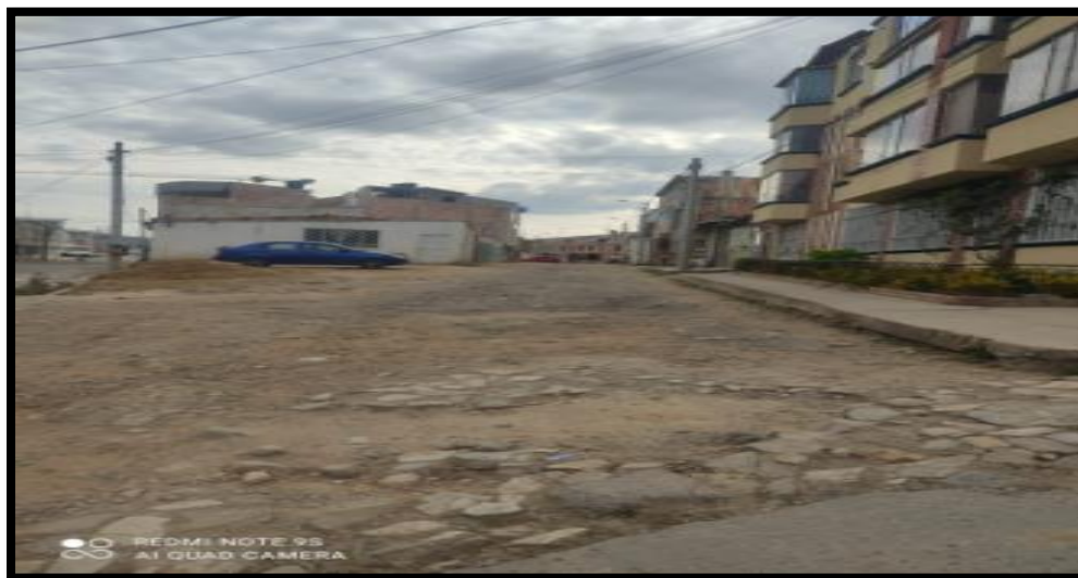
Figura 100. Tramo 23 G. cra 9 a desde calle 6 e sur hasta calle 6 sur.
