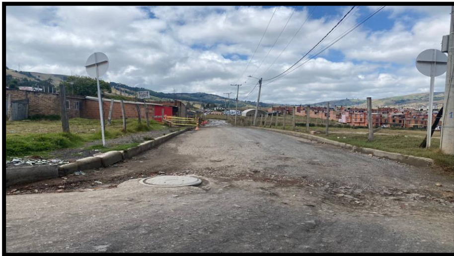
Figura 90. Tramo 21 A. la vía Tunja – villa pinzón con calle 6ª a
