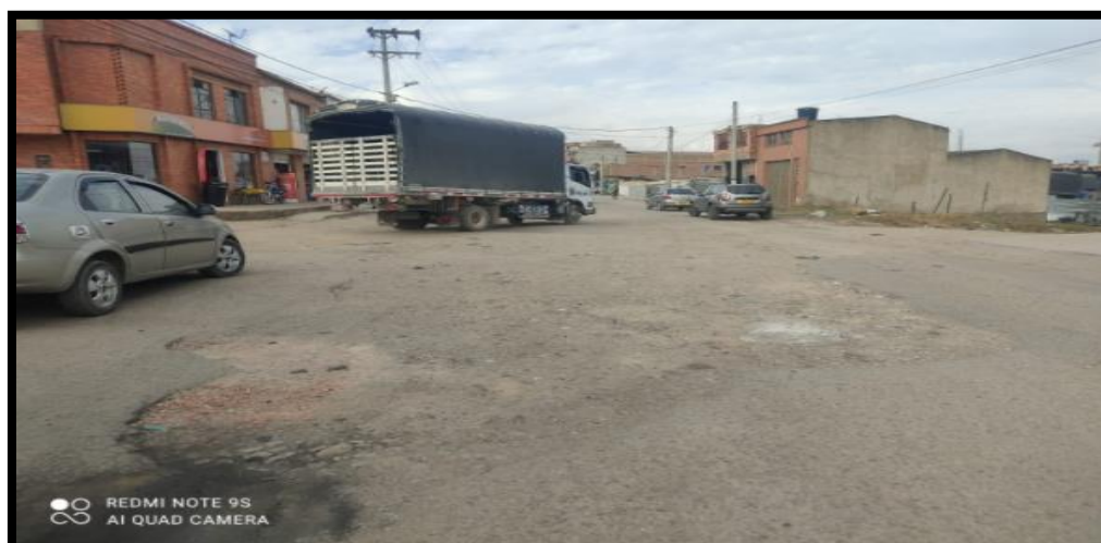
Figura 97. Tramo 23 D. cra 13 desde calle 6dsur hasta calle 5 a sur.
