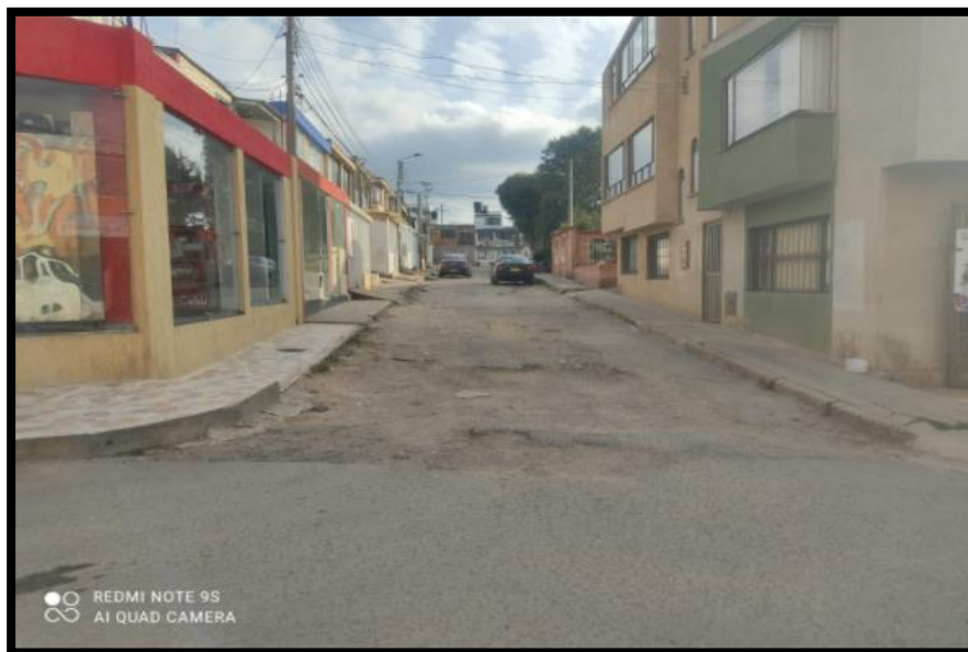
Figura 80. Tramo 17 I. carrera 3 a entre calle 4 d y calle 5 salida.
