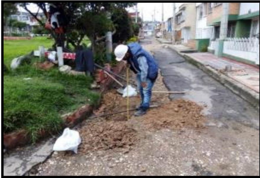
Figura 9. Apique para sacar muestras para laboratorio.
