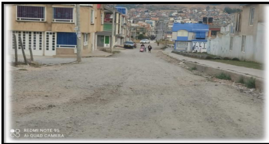
Figura 83. Tramo 18 A. calle 4 a bis desde cra 6 hasta cra 4 c y continuidad cra 4 c desde calle 4 a bis hasta calle 5.
