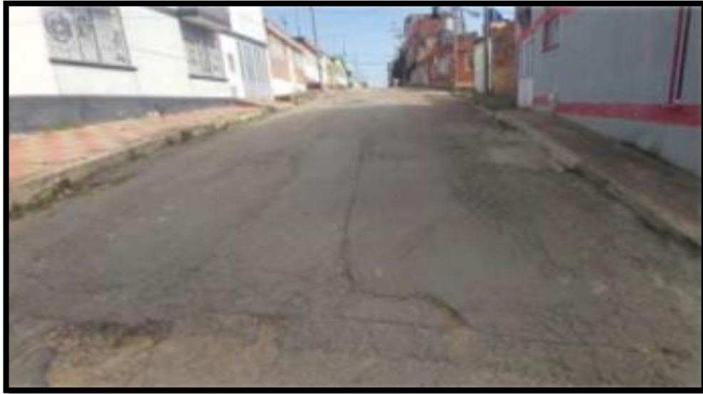
figura 35. Tramo 4 B. cra 7 entre calle 60 y 61.
