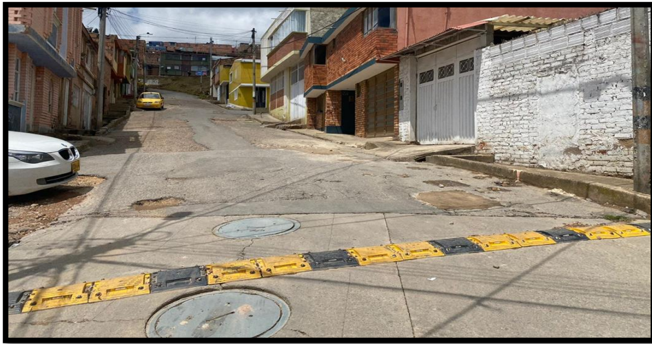
Figura 117. Tramo 28 B. calle 26a con cra 1.
