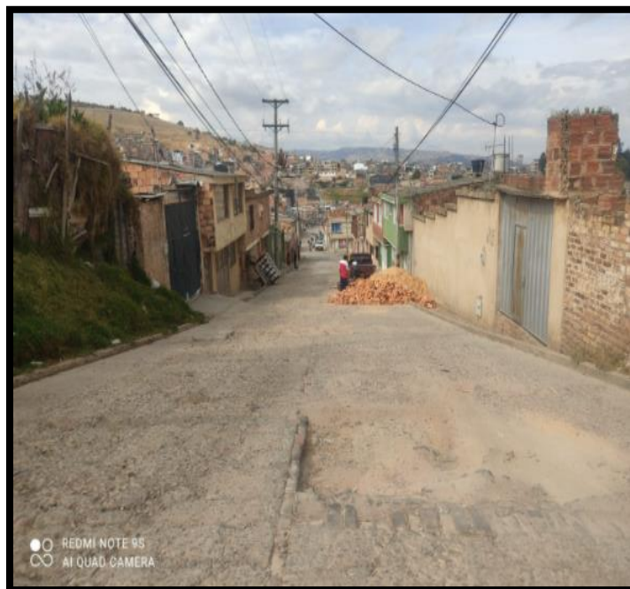
Figura 106. Tramo 25 B. carrera 17 entre calle 6 y 7.
