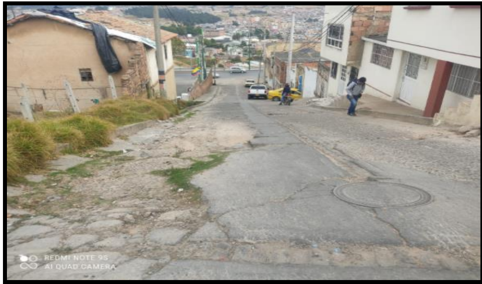
Figura 103. Tramo 24 A. calle 7 desde cra 10 hasta av. oriental cra 6.
