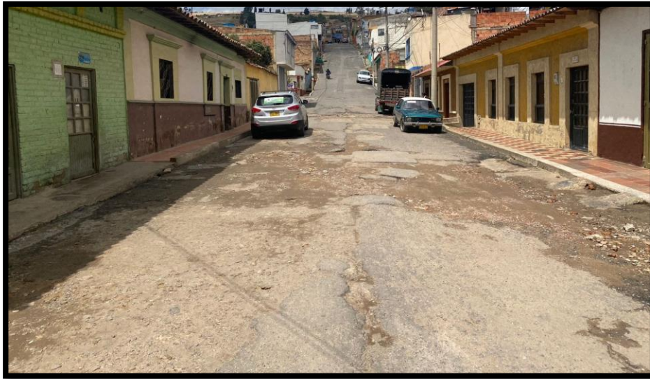
Figura 119. Tramo 29 A. calle 24 entre cra 14 y cra 16.
