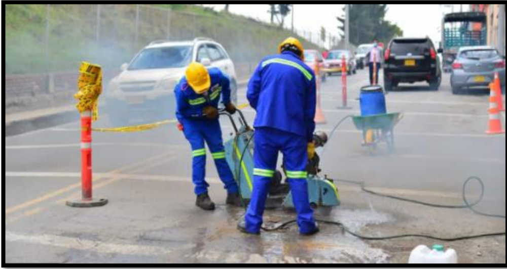
Figura 20. Intervención a via de la ciudad de Tunja.
