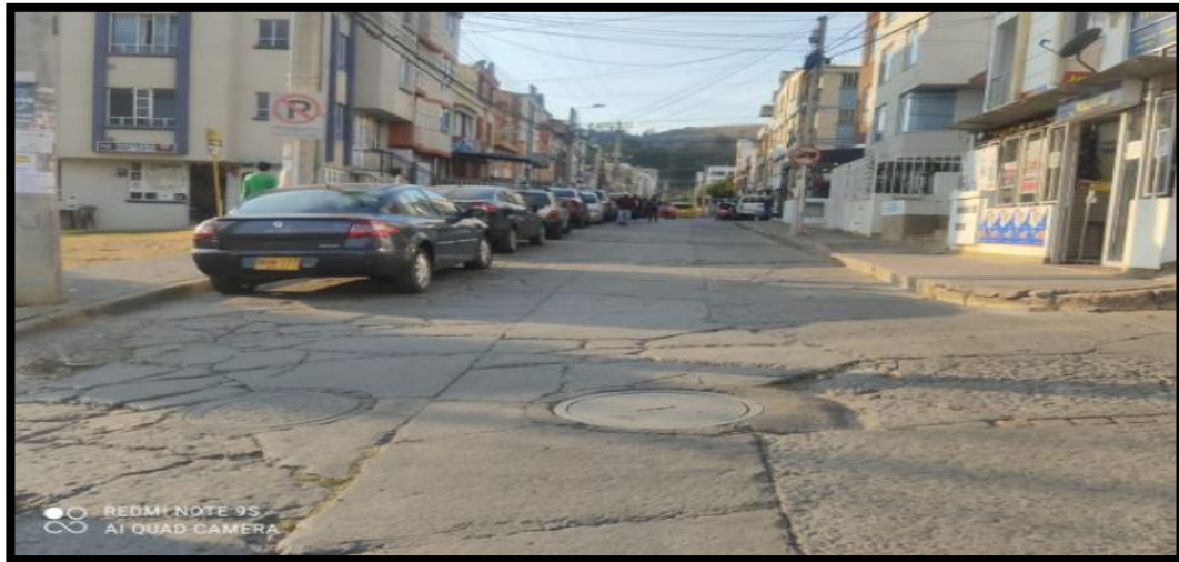
Figura 25. Tramo 1 A. calle 73 desde cra 2 a este hasta tranv. 2 a
