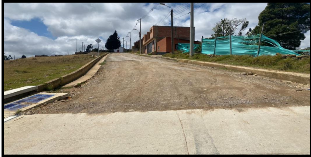
Figura 114. Tramo 27 C. vía desde acceso de San Lázaro, bajando por calle 31.
