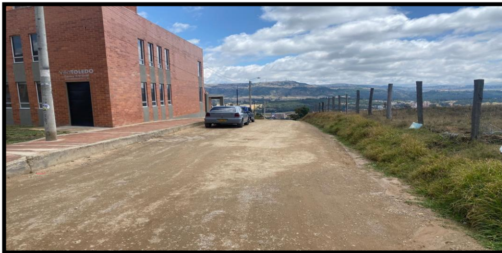
Figura 44. Tramo 6 C. calle 53 desde carrera 16 hasta carrera 14.
