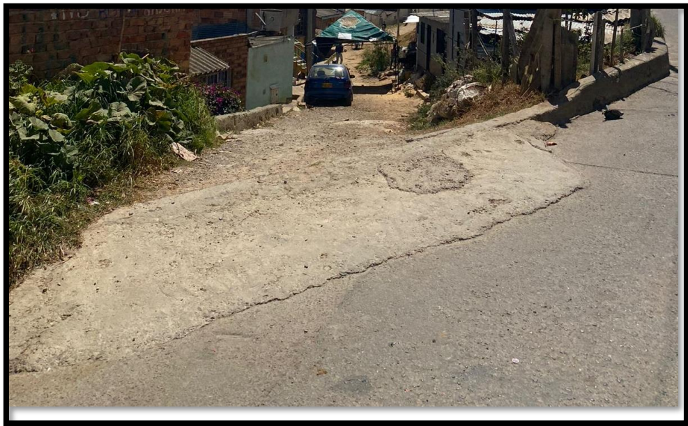
Figura 110. Tramo 26 A. callejón atrás del topo trasversal 17 a.
