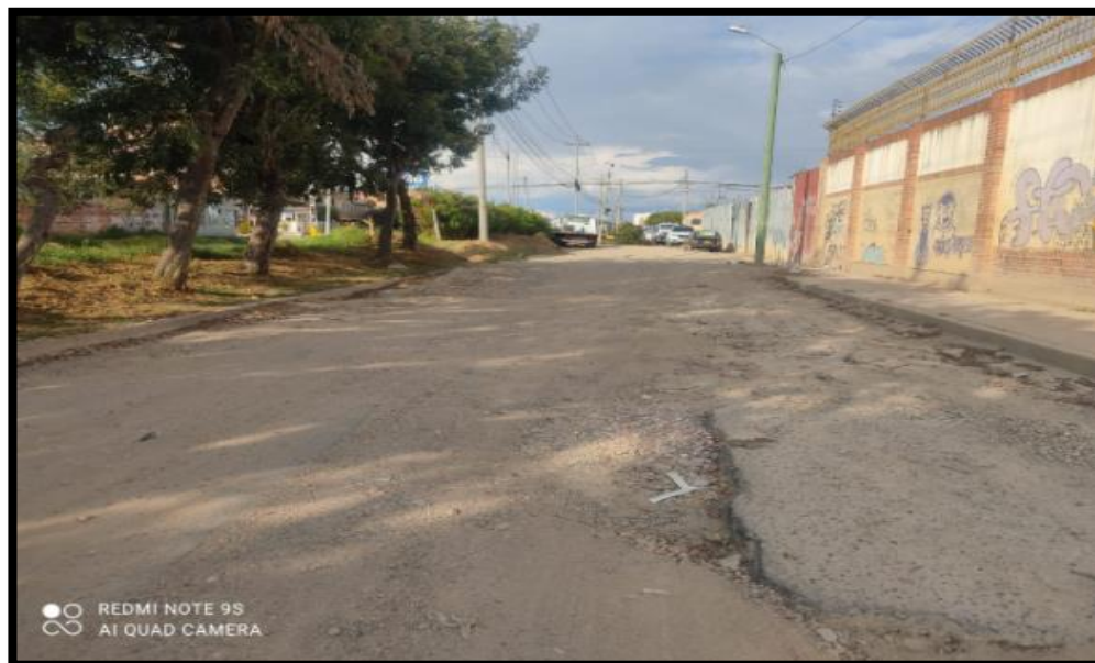
Figura 57. Tramo 10 A. paralela a la carrilera – carrera 5 a hasta acceso al barrio.
