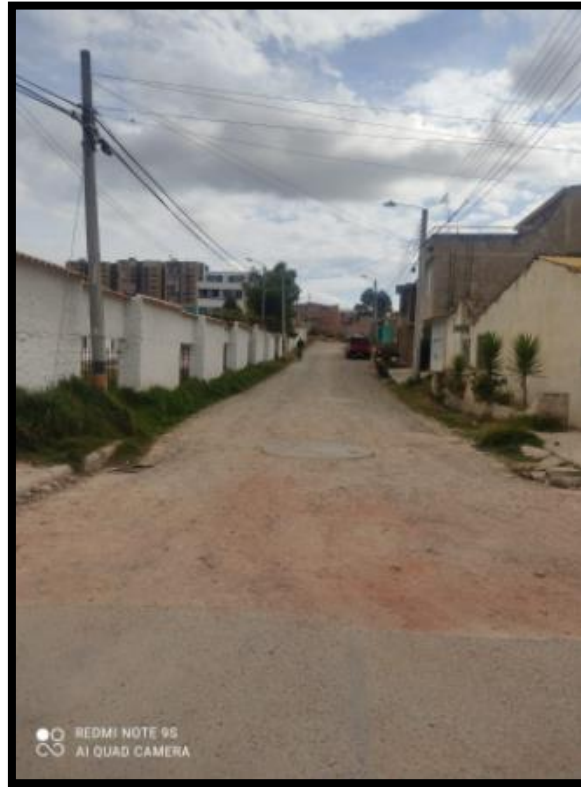
Figura 70. Tramo 16 A. calle 18 con carrera 2ª hasta calle 17e y calle 17e entre carrera 2 y carrera 2 a.
