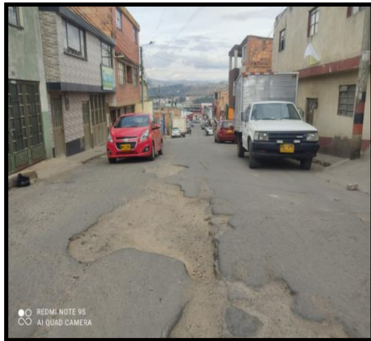
Figura 108. Tramo 25 D. calle 6 con cra 1.
