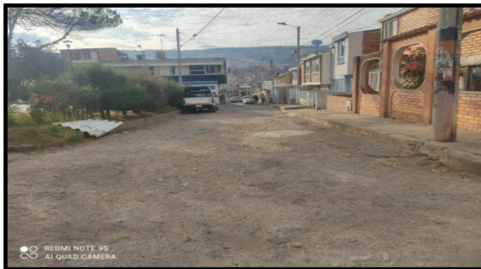
Figura 76. Tramo 17 E. calle 4 d entre carrera 4 y 3 a.
