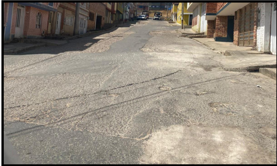
Figura 116. Tramo 28 A. calle 29 con cra 18 al costado del salón comunal
