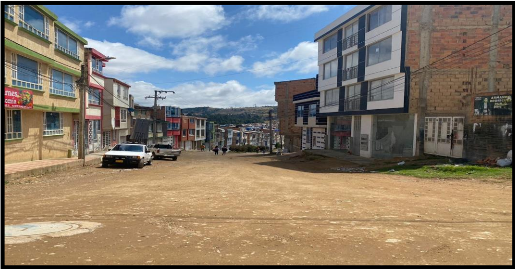
Figura 86. Tramo 19 A. calle 5 a entre cra 6 y cra 5 d acceso al barrio.
