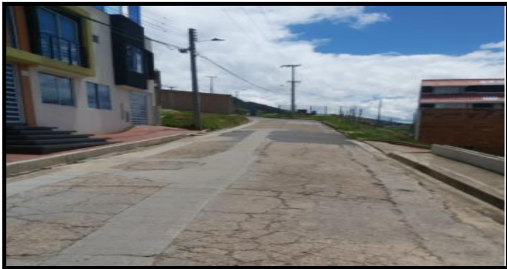
figura 47. Tramo 7 B. carrera 15 entre calle 47 y calle 49.
