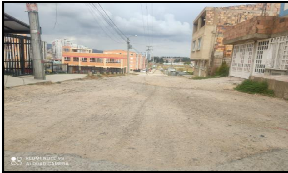
Figura 67. Tramo 15 A. carrera 4 desde calle 15 hasta calle 18.
