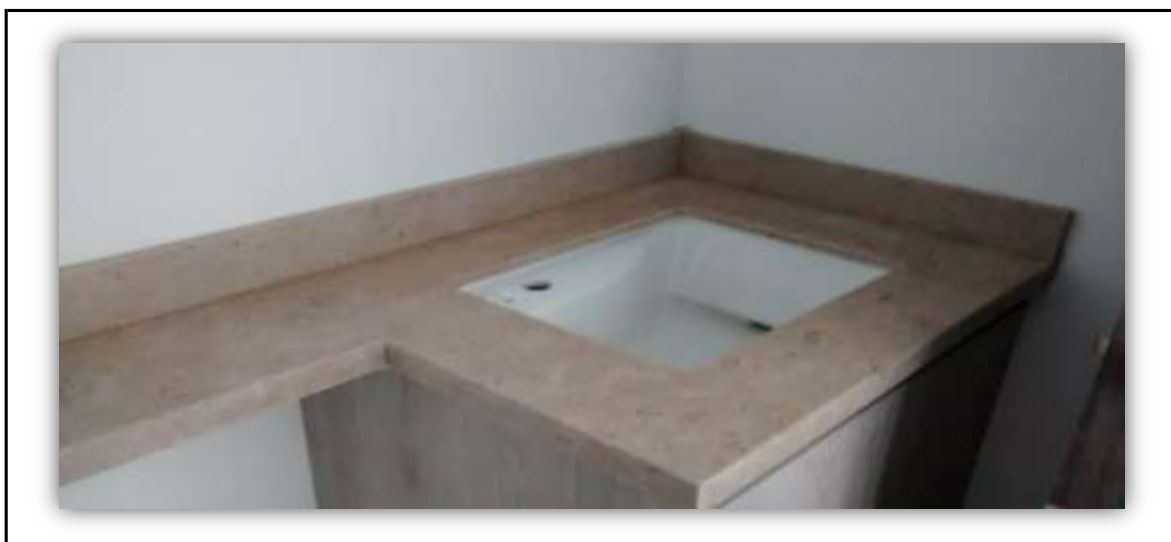
Ilustración 10. Acompañamiento instalación de mármol y granito.
