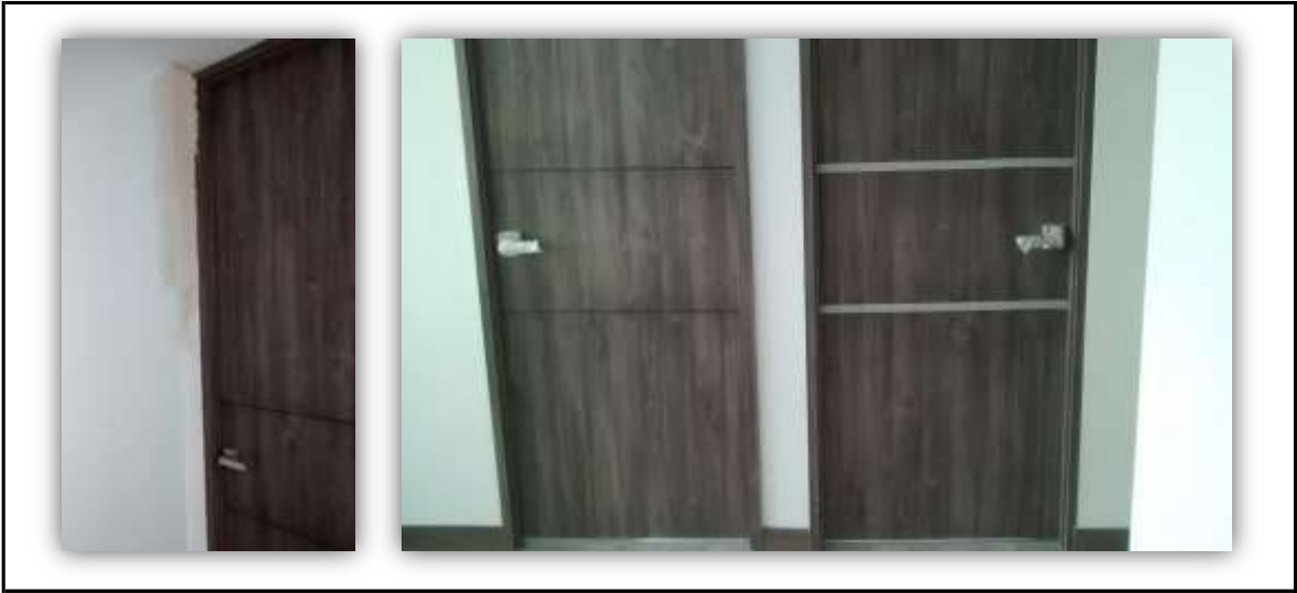
Ilustración 6. Seguimiento acabado de puertas apartamentos torre 5.
