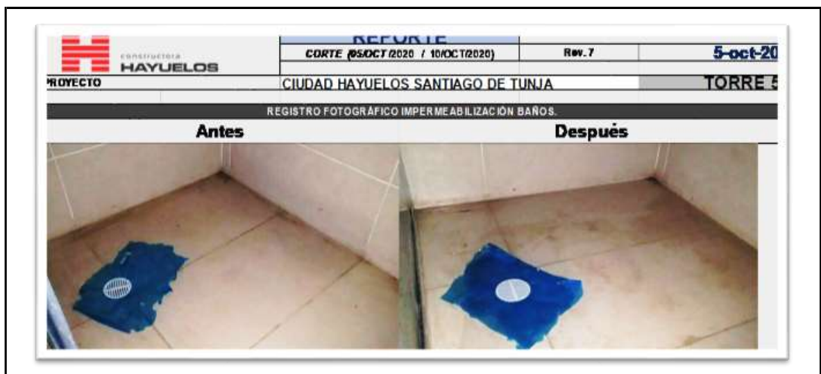
Ilustración 8. Pruebas de estanqueidad al enchape de los cuartos de ducha.
