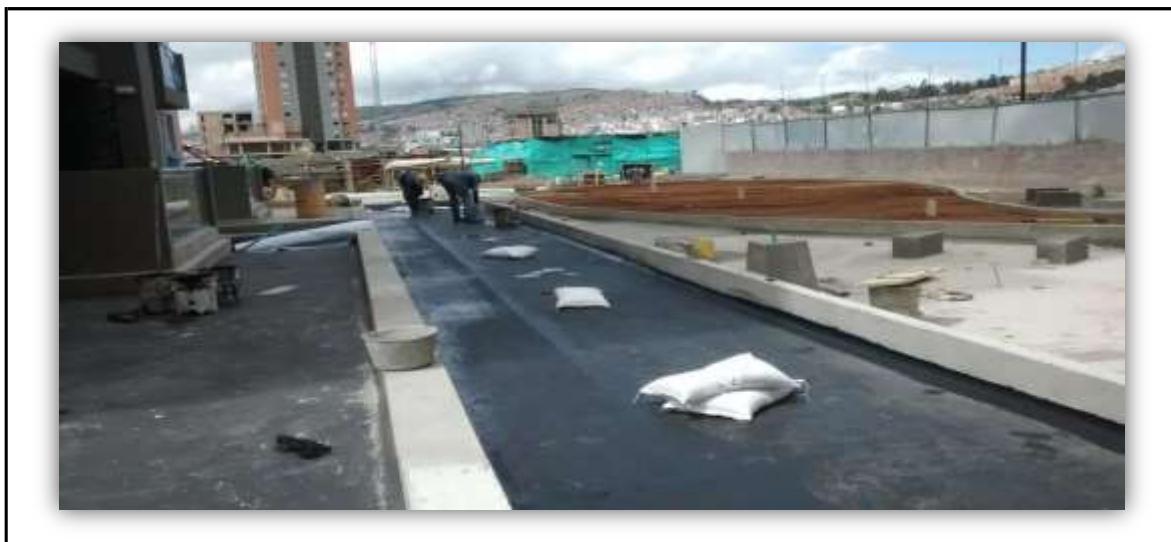
Ilustración 25. Seguimiento a impermeabilización en plataforma.
