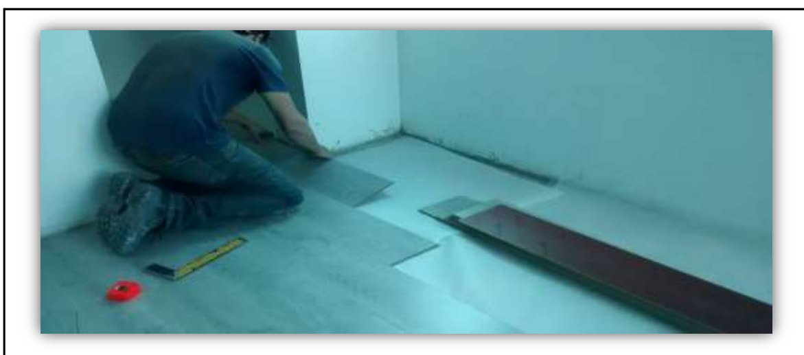
Ilustración 9. Seguimiento instalación piso laminado.
