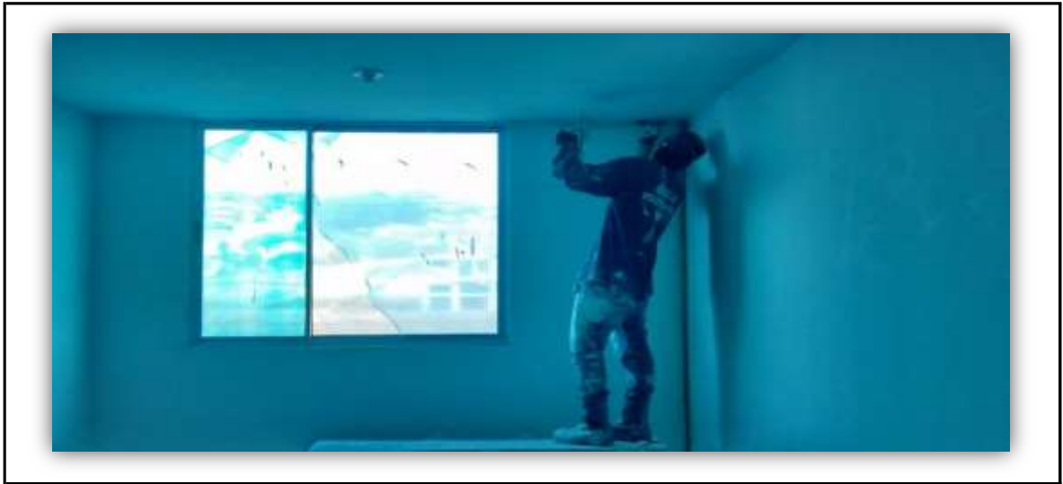
Ilustración 11. Seguimiento detallado y lijado de pintura tercera mano.
