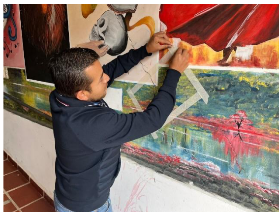
Figura 18. Instalación de testigos para control de fisuras fuente propia, en el muro de la entrada principal.
