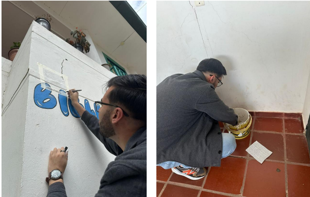
Figura 15. Instalación de testigos para control de fisuras fuente propia, sobre la fachada principal.
