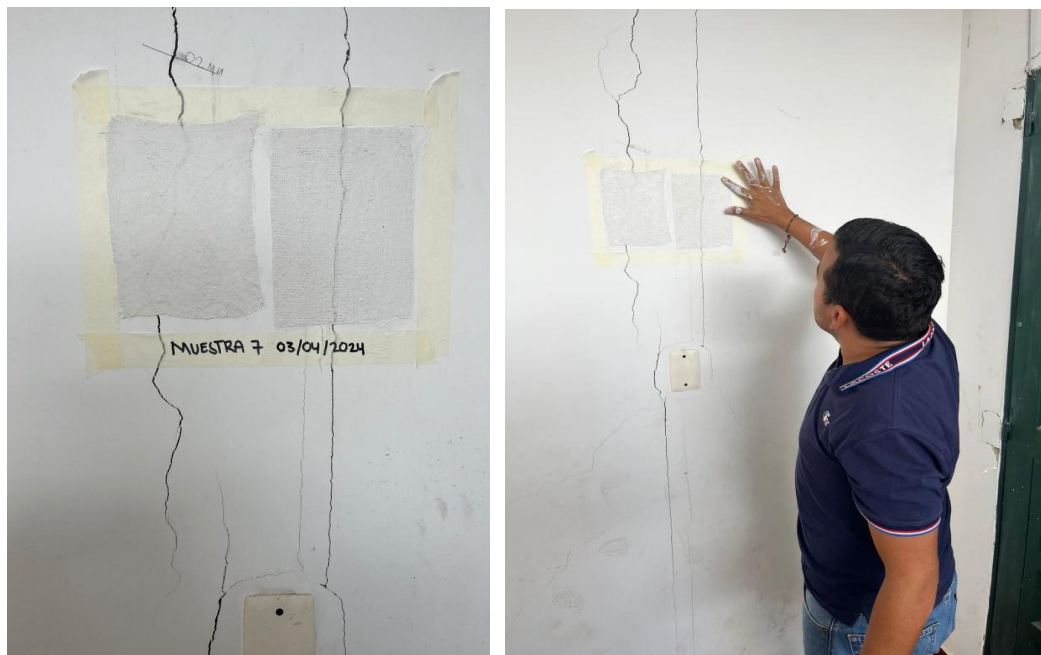
Figura 16. Instalación de testigos para control de fisuras fuente propia, sobre los muros de circulación del piso dos.
