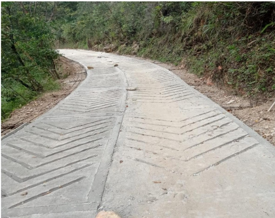
Imagen 27. Placa huella construida
