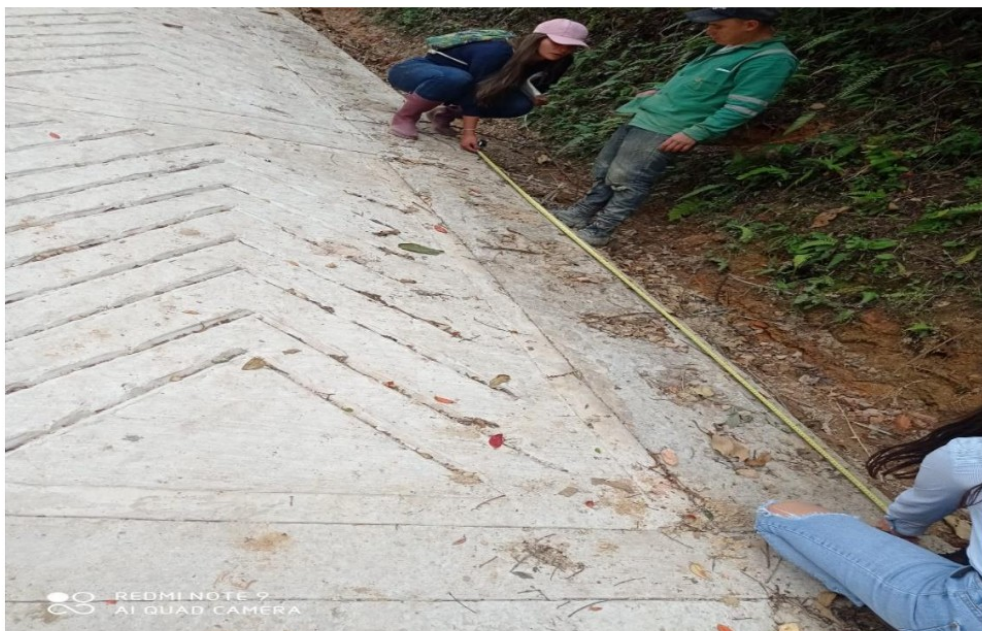
Imagen 28. Medición tramos construidos placa huella
