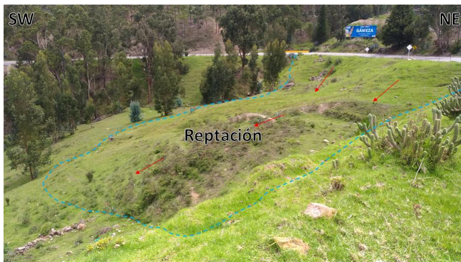
Fotografía 24 Reptación en el municipio de Gámeza
