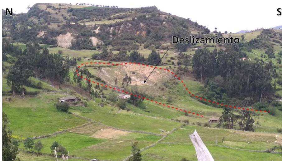
Fotografía 25 Deslizamiento en el municipio de Gámeza
