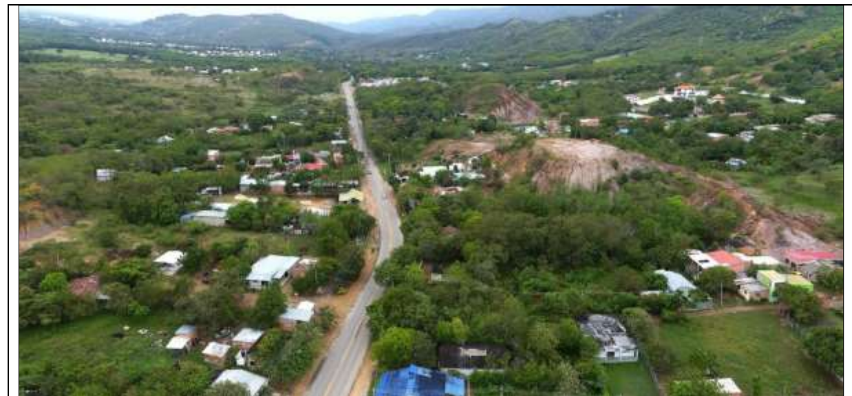
Ilustración 14. PR 6+500 Vista Sentido Norte - Sur
