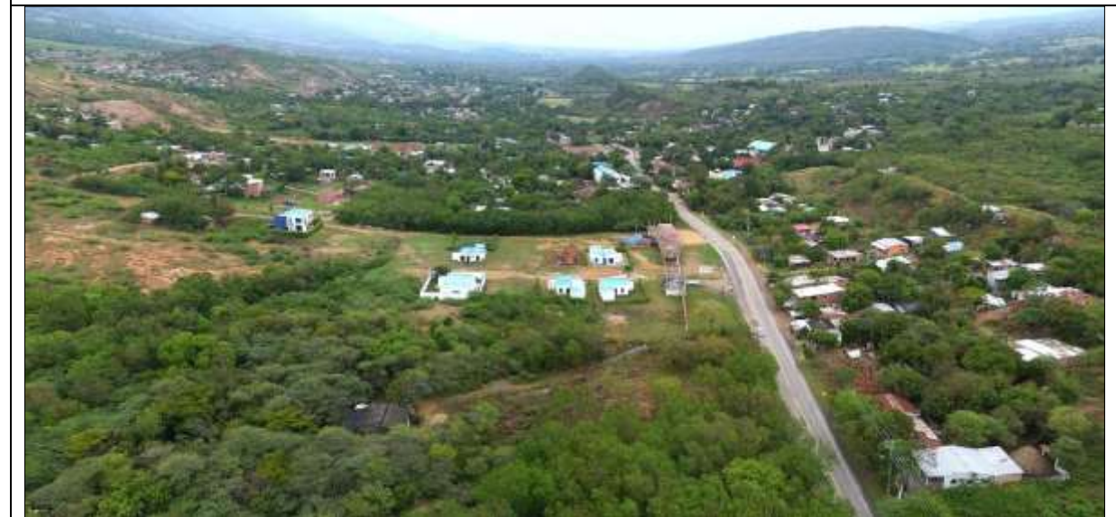
Ilustración 15. PR 6+500 Vista Sentido Sur - Norte
