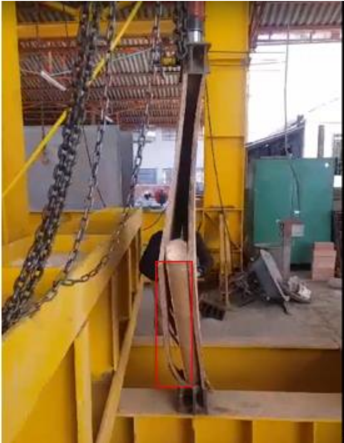
Ilustración 38. Falla de Panel 2.
