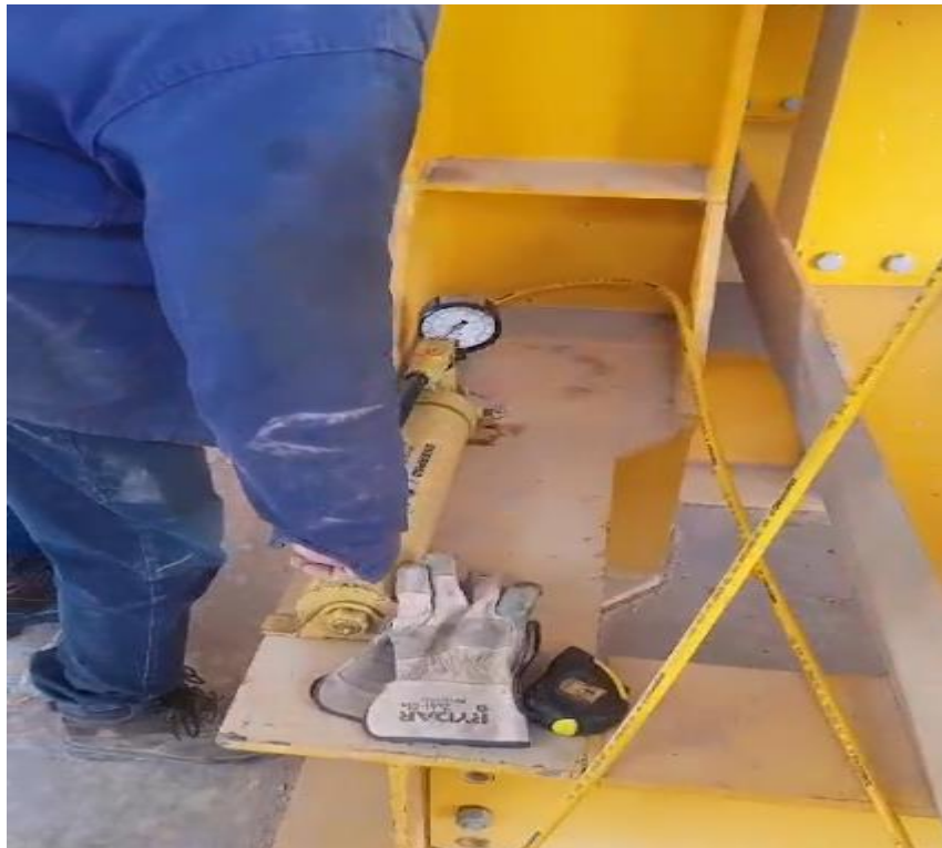
Ilustración 26. Detalle de presión con gato hidráulico por funcionario UNAL.
