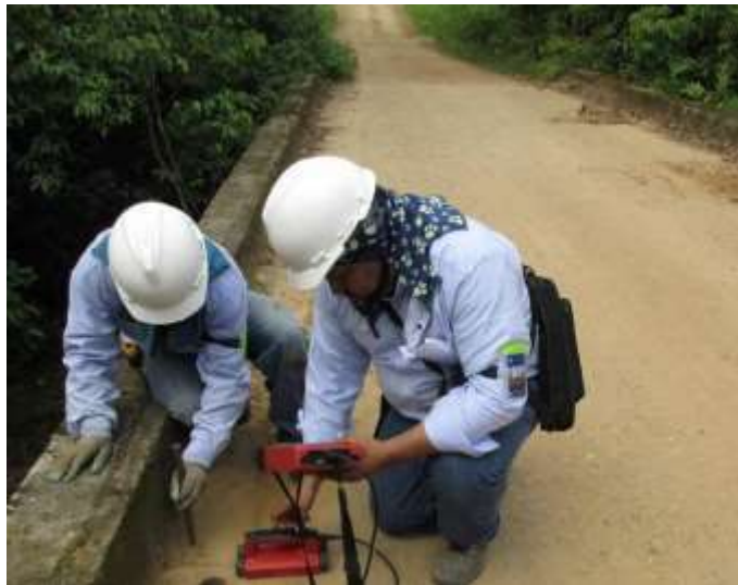
Figura 43. Escáner del tablero de la superestructura por el especialista
