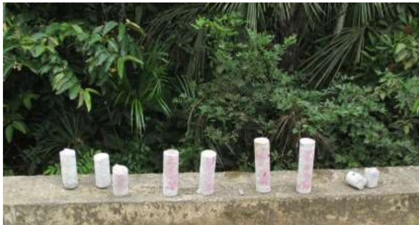
Figura 52. Ensayo de carbonatación.
