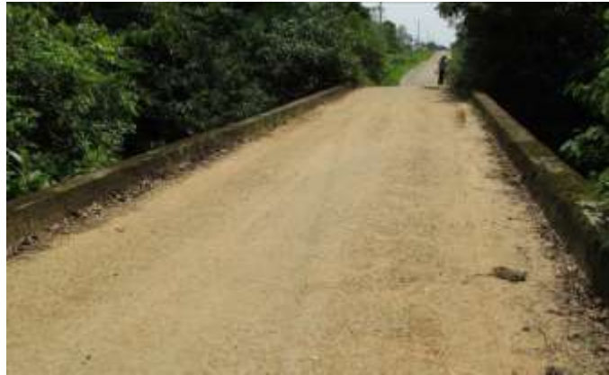
Figura 7. Detalle de la losa superior del puente
