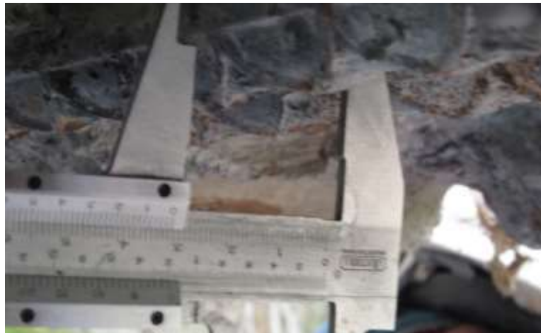
Figura 58. Comprobación del número de barras y diámetro de las vigas de la superestructura
