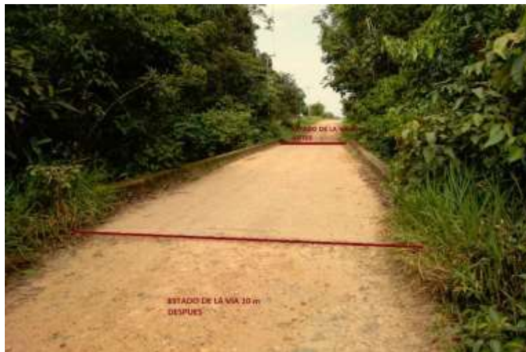
Figura 25. Vista de los materiales de la vía 10 m antes y después del Puento
