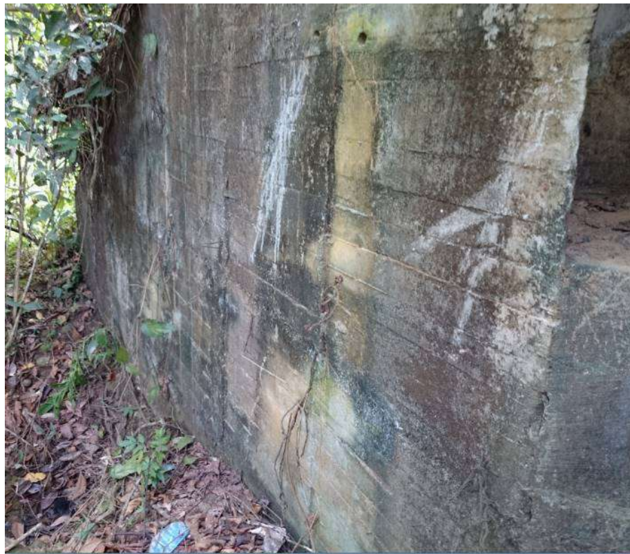
Figura 37. Detalle de unión de Aleta y Estribo
