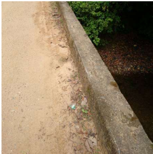
Figura 30. Detalle de bordillo del puente
