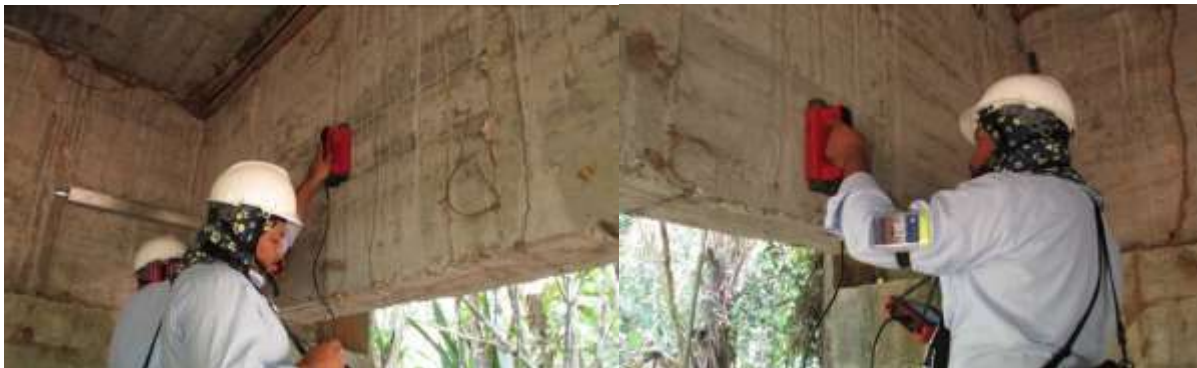
Figura 54. Procedimiento de Escaneo de Vigas de la superestructura
