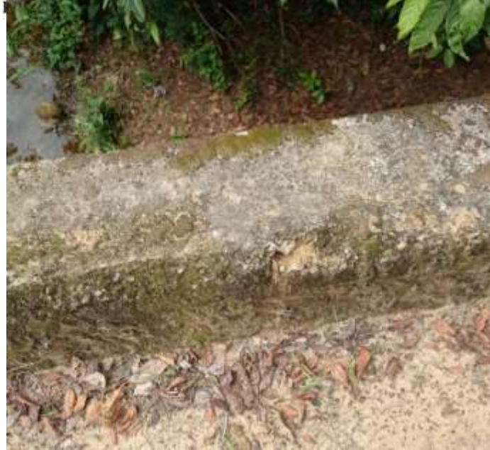
Figura 31. Verificación del estado de los bordillos
