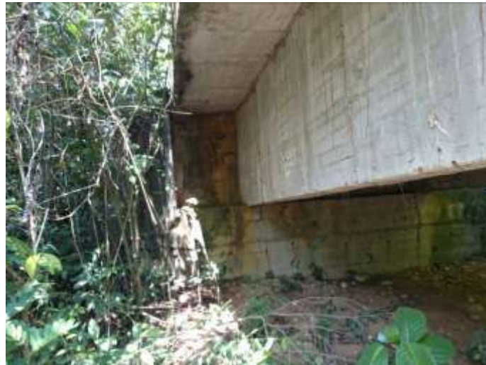
Figura 6. Detalle de estribo Norte
