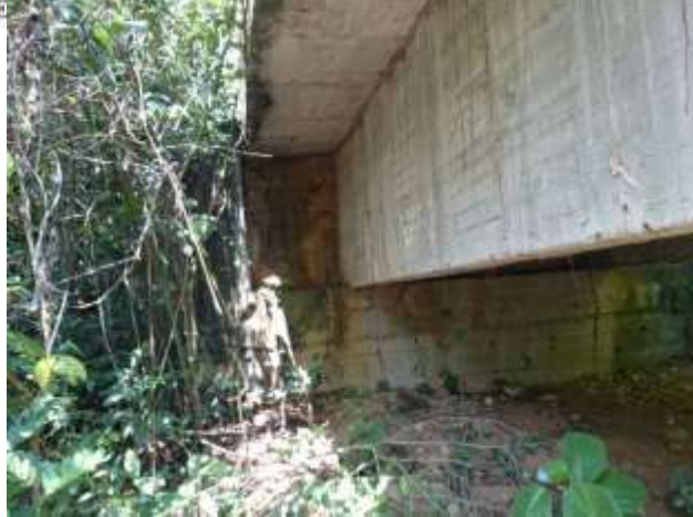
Figura 9. Detalle Estribo Puente
