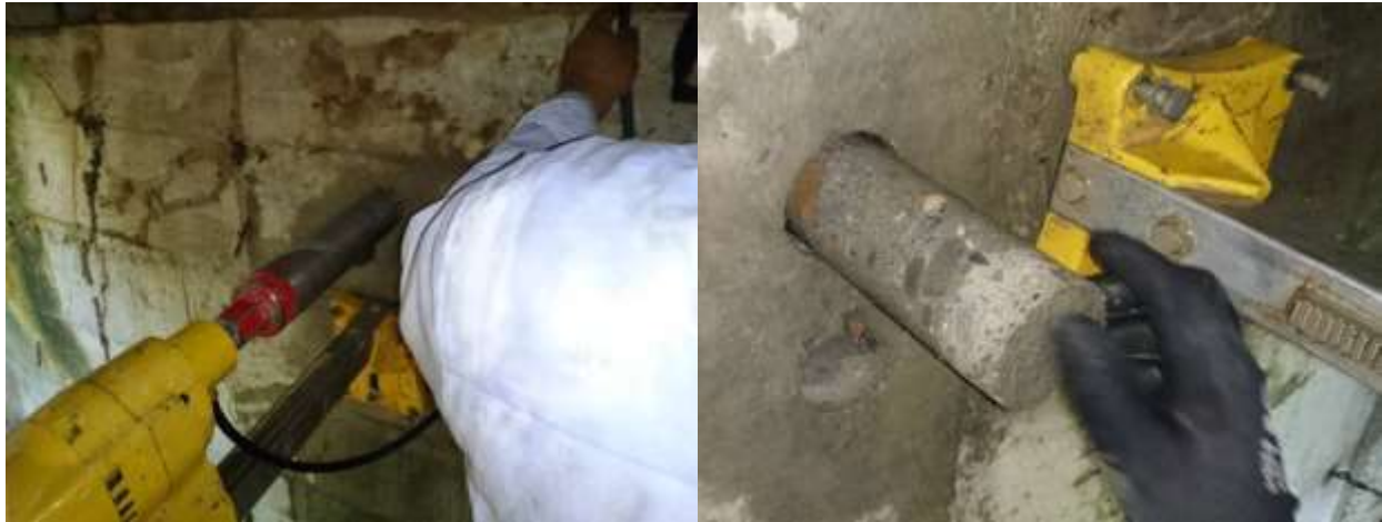
Figura 63. Extracción de núcleos en el estribo del puente
