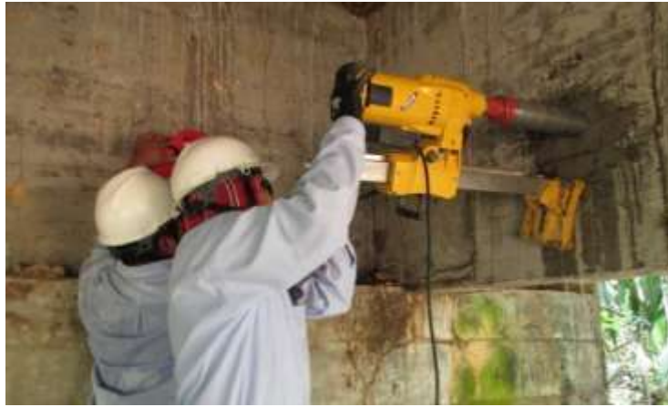
Figura 65. Extracción de núcleos en vigas.
