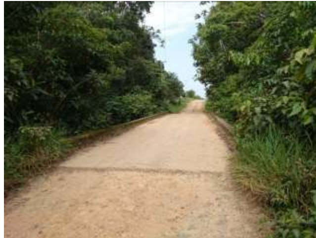
Figura 2. Puente sobre el caño Manacal vista superior.
