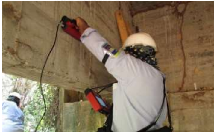
Figura 53. Escáner Japonés 3D – Especialista realizando el escáner de la viga de la superestructura
