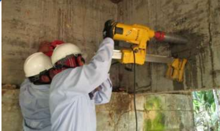
Figura 15. Equipos de Patología Estructural
