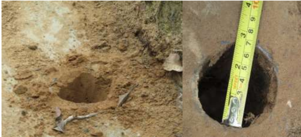
Figura 35. Drenajes de la losa.
