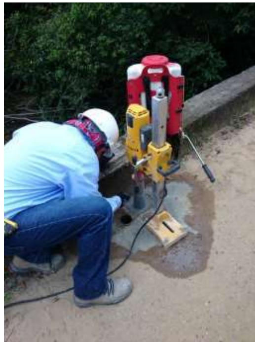
Figura 64. Extracción de núcleos losa superestructura
