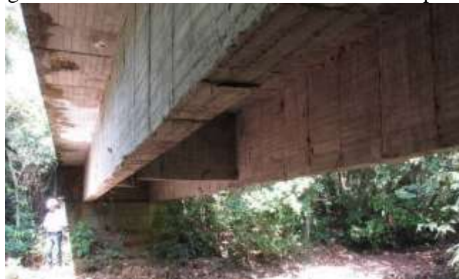
Figura 3. Vista inferior del Puente
