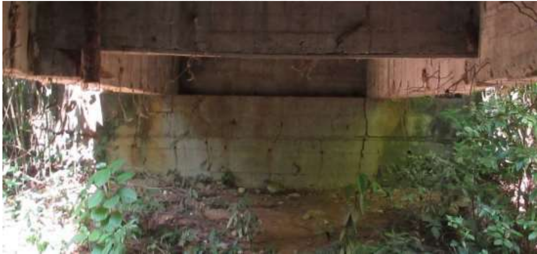
Figura 5. Estribo Norte del puente.
