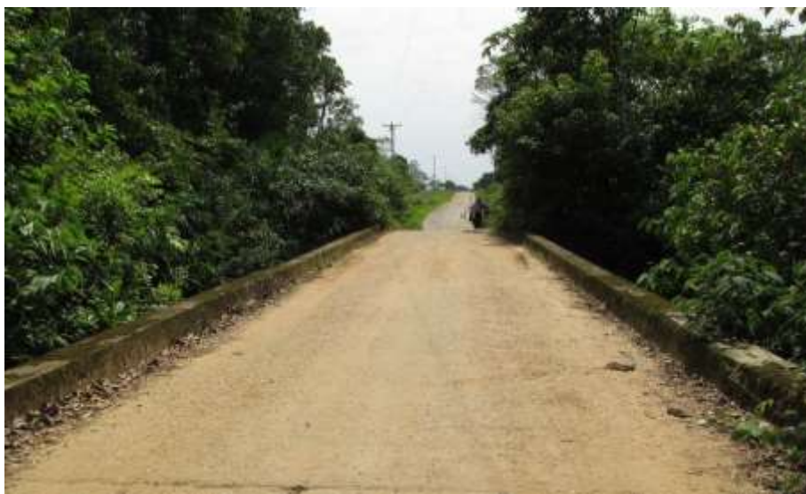
Figura 17. Puente sobre el Caño Manacal.
