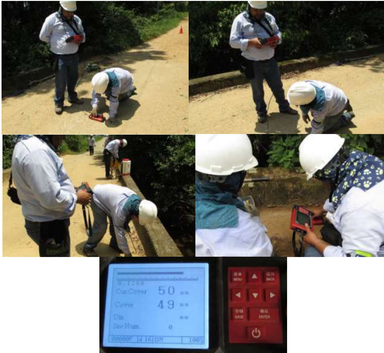
Figura 60. Evidencia de escaneo de elementos estructurales del puente
