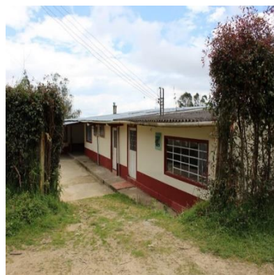
Figura 21 Casas de bloque del Sector Monterrico- Agua Bonita
